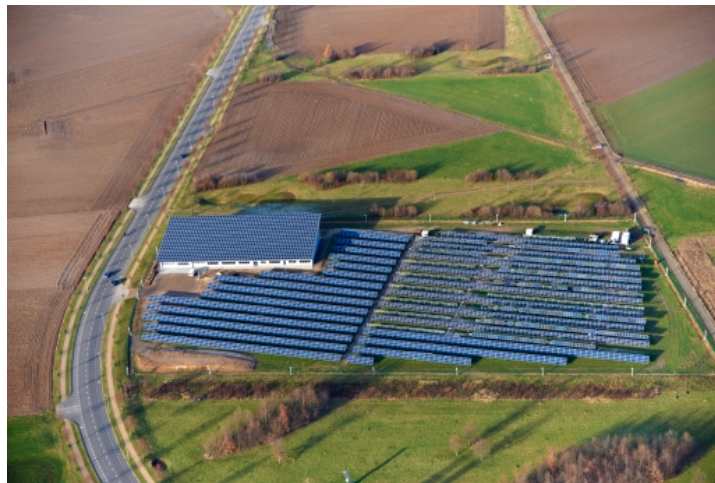
Figura 8-11 Sitio de prueba de mediciones de rendimiento de PHOTON Laboratory en Aachen, Alemania
