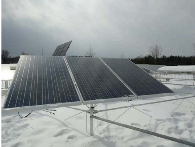
Figura 8-1 Labores de instalaciones realizadas en Kortright Center
