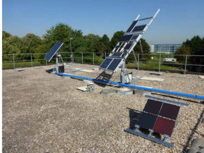
Figura 8-12 Plataformas instaladas en el techo de LGEP, París
