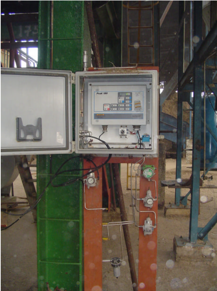
Foto 7.5 Panel de control del gobernador electrónico Peak 150.
