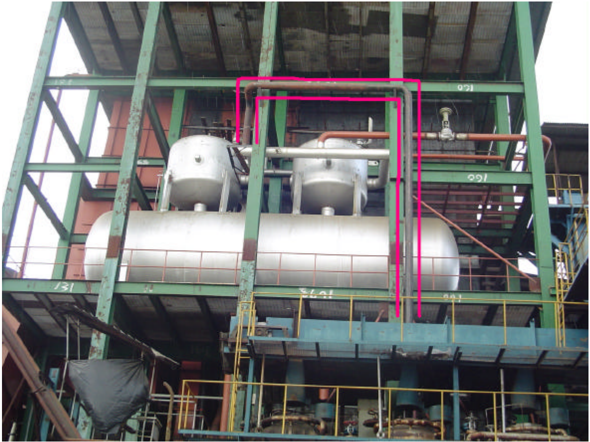
Foto 7.3 Instalación de tubería en el cabezal de los deaireadores.
