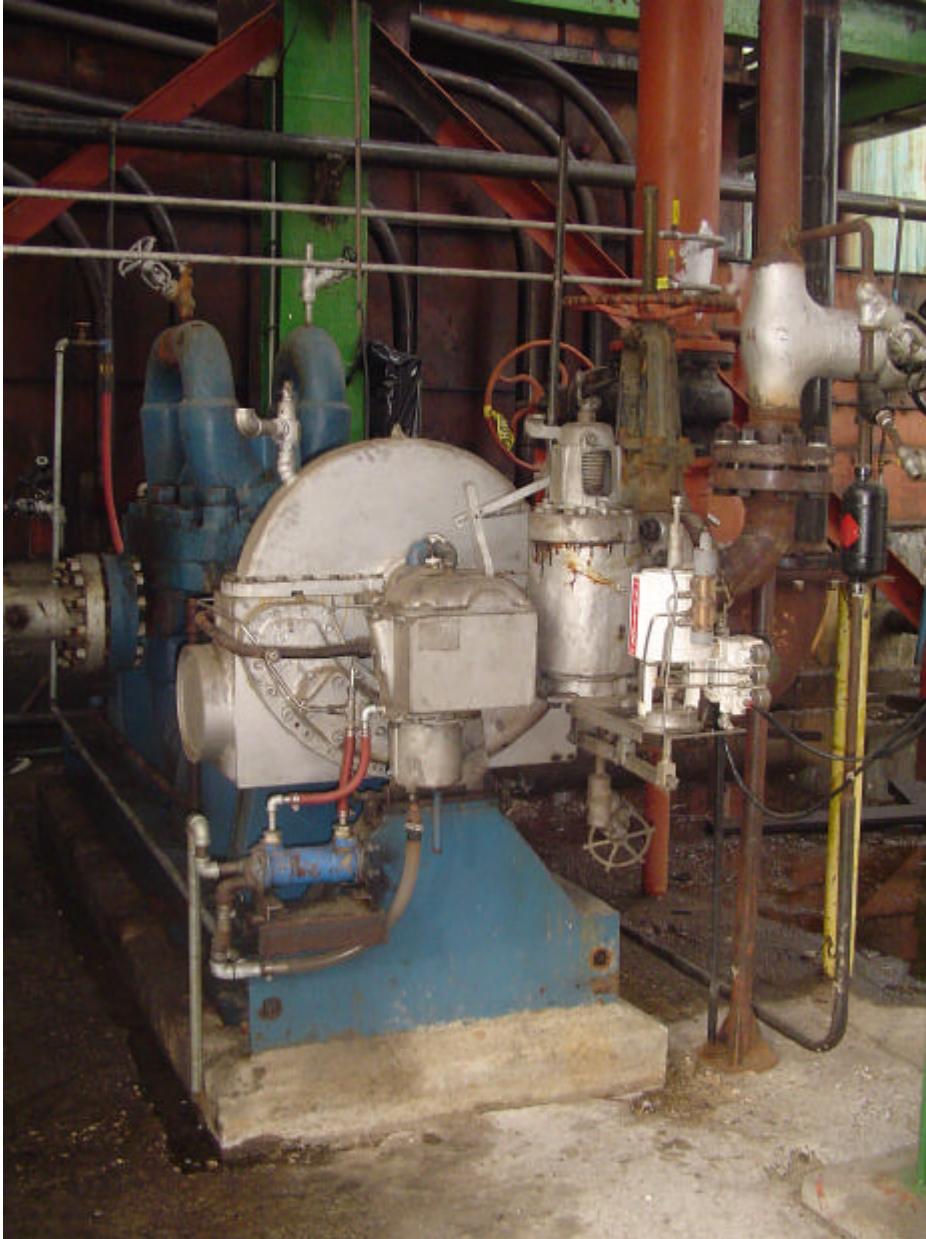
Foto 7.9 Instalación completa de la turbina.
