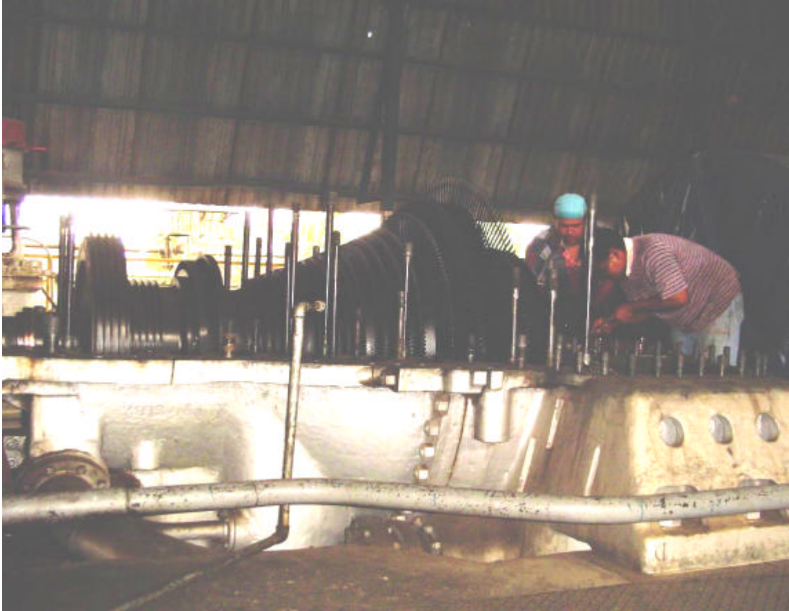
Foto 12.1 Mantenimiento del turbo-generador #1.
