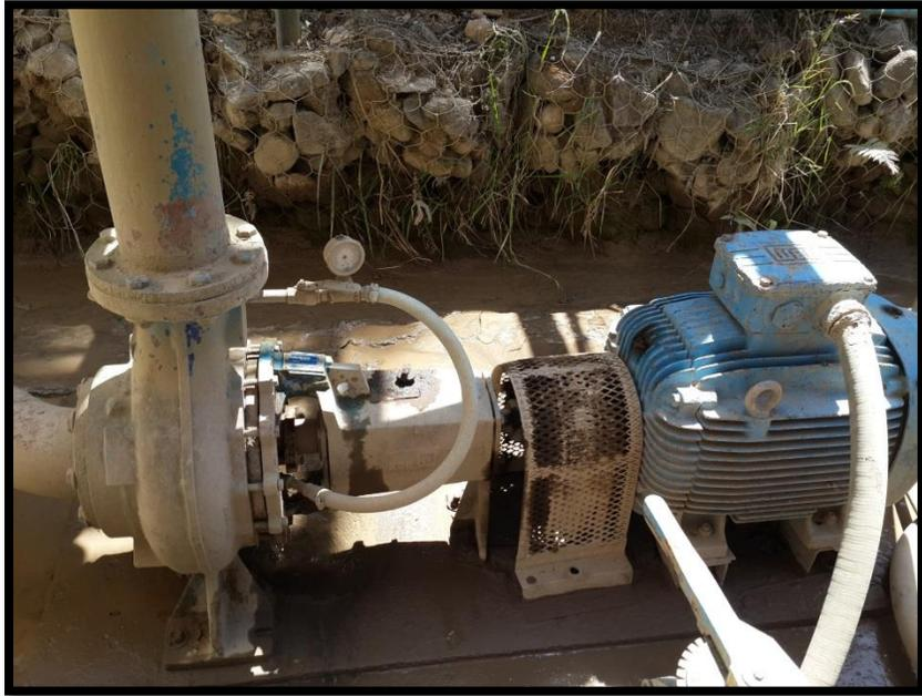
**Figura 4.4.** Bomba centrifuga utilizada en el sistema de lavado de la planta.
