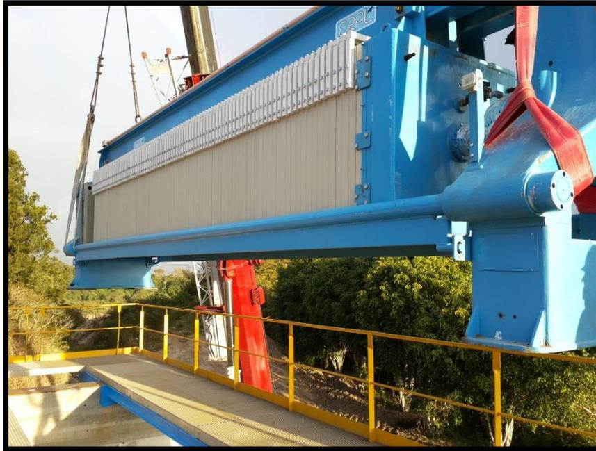
**Figura 3.9.** Izaje del filtro prensa.
