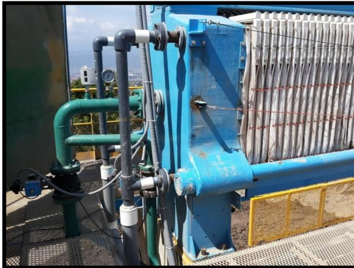
**Figura 2.2.** Cabezal fijo y conexiones de tuberías.
