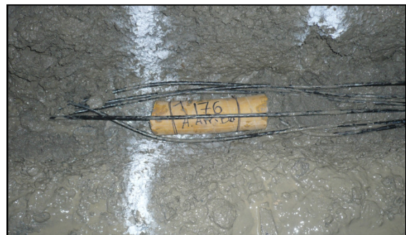
Figura 44. Instalación de un termómetro con protección. Fuente Departamento de Auscultación de Obras, ICE, 2009.
