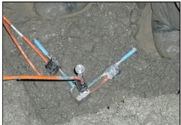
Figura 48. Colocación del deformímetro. Fuente Departamento de Auscultación de Obras, ICE, 2009.
