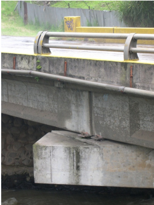
Figura 16. Vigas principales apoyadas sobre la pila central
