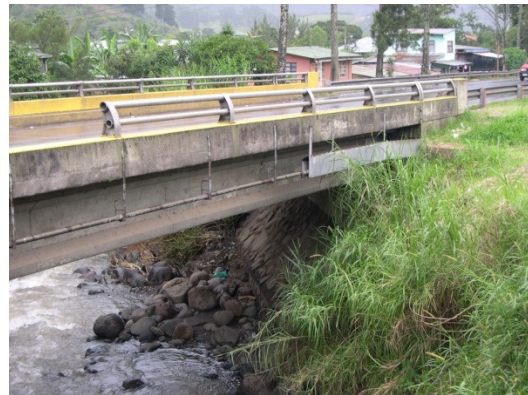
Figura 15. Apoyo en bastión de la margen derecha
