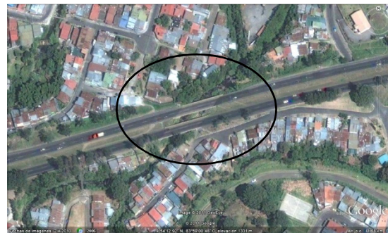
Figura 10. Ubicación del puente sobre el río La Cruz
