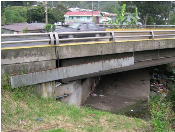
Figura 13. Apoyo en bastión de la margen izquierda
