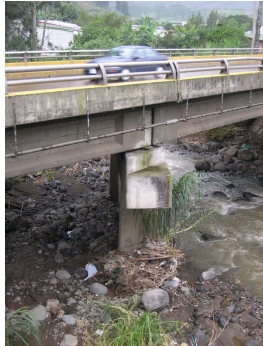
Figura 14. Apoyo sobre pila central
