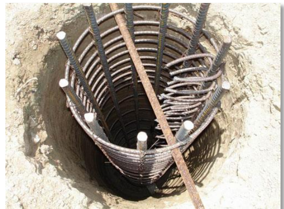
Figura 27. Pilotes y caissons (Fuente: el autor)
