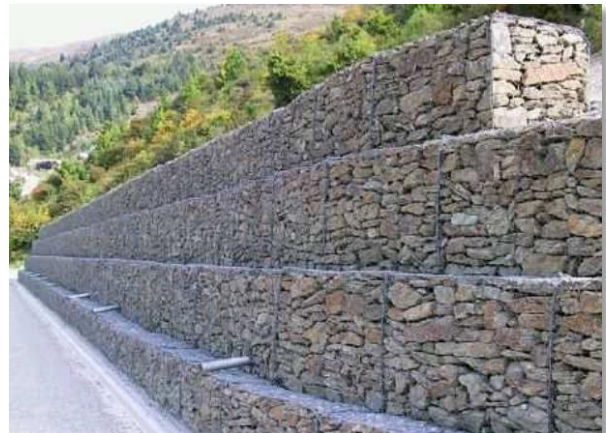
Figura 18. Muro de Gaviones (Fuente: el autor)
