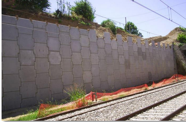
Figura 21. Muro de tierra armada. (Recuperado de http://www.murolud.com )
