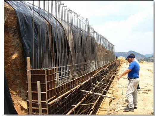
Figura 22. Muro de concreto reforzado. (Recuperado de http://www.guiaconstruccion.net )
