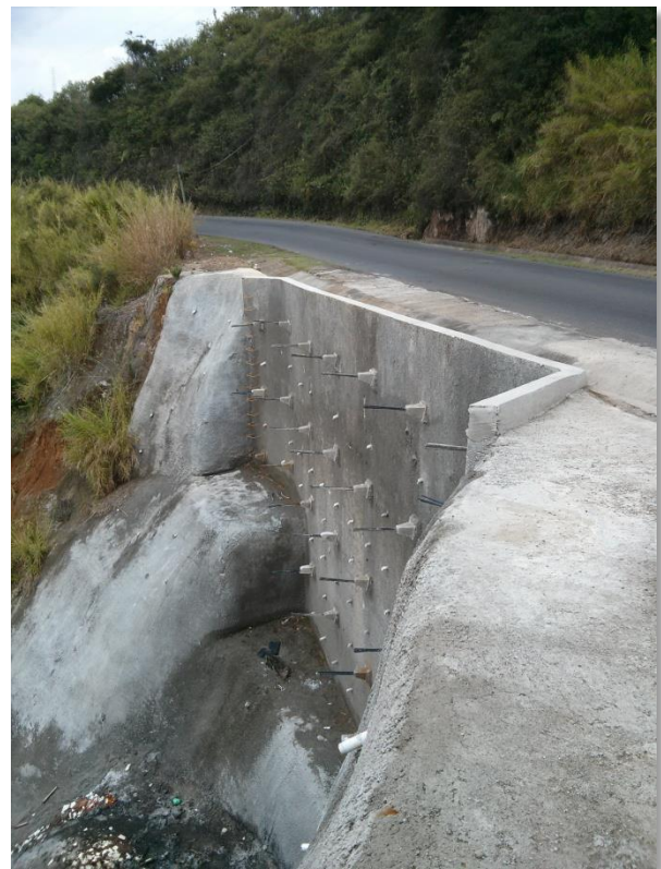
Figura 48. Estructura, Estación 1+575 (Fuente: el autor)
