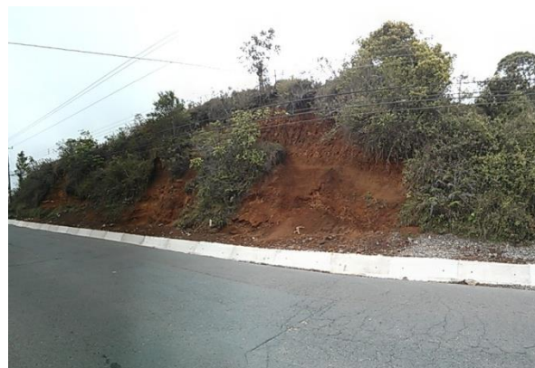
Figura 51. Talud, Estación 14+840 (Fuente: el autor)
