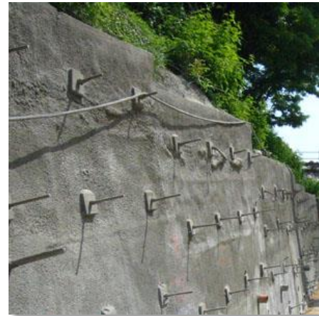
Figura 26. Soil nailing (Fuente: el autor)
