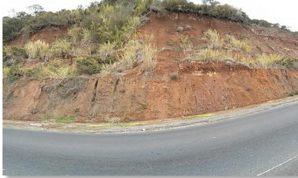
Figura 49. Talud C, Estación 1+605 (Fuente: el autor)
