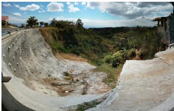
Figura 25. Pantalla anclada (Fuente: el autor)
