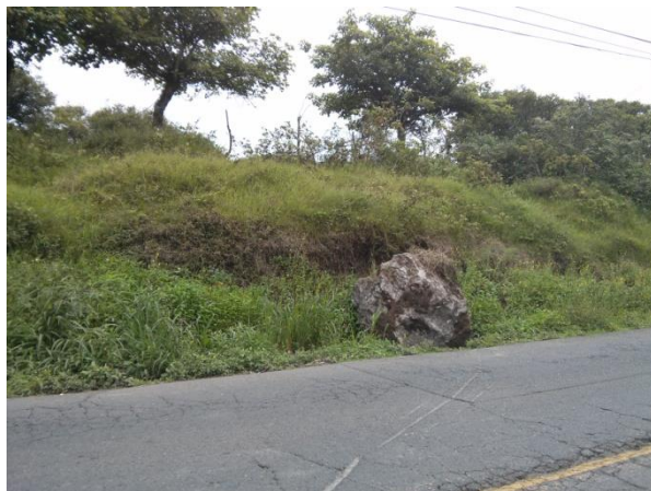
Figura 50. Ladera, Estación 12+970 (Fuente: el autor)
