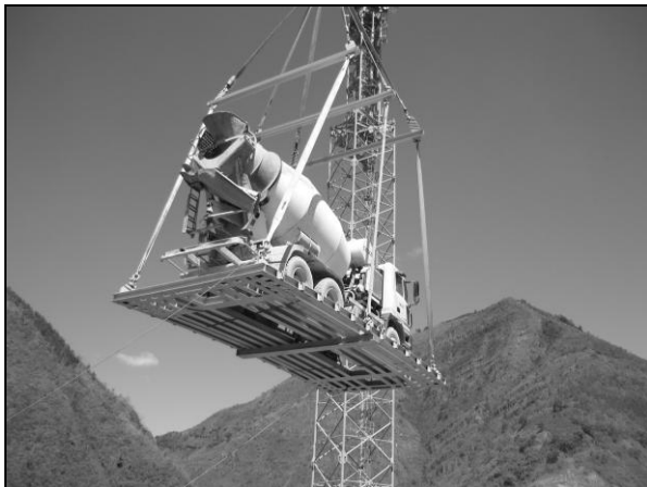
Foto 56. Proceso de levantamiento y extracción de maquinaria de la presa, con la grúa de alta capacidad
