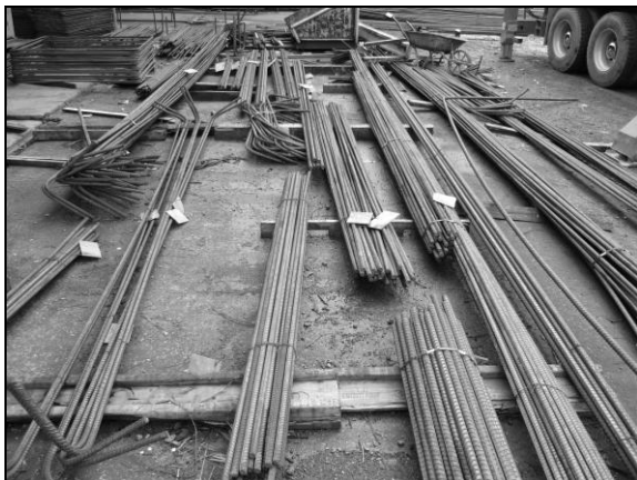
Foto 35. Despiece de acero estructural (etiquetado según nomenclatura de la cartilla de despiece), en el taller de doblado
