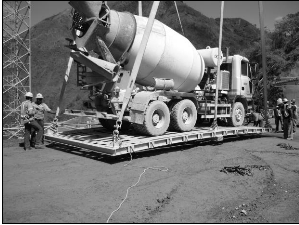
Foto 55. Plataforma de izaje para sacar maquinaria de la presa, manejada con la grúa de alta capacidad
