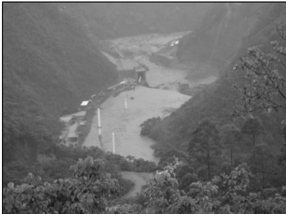
Foto 82. Ingreso del río Pirrís a la fundación de la presa (sobrepasó la ataguía), “Sitio Presa”, 29 de mayo 2008
