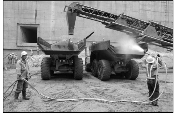
Foto 64. Cargado de RCC en las vagonetas articuladas, con el sistema banda transportadora - Crawler
