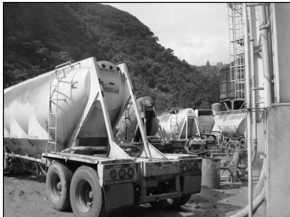
Foto 25. Camiones graneleros para el transporte del cemento en la planta de RCC
