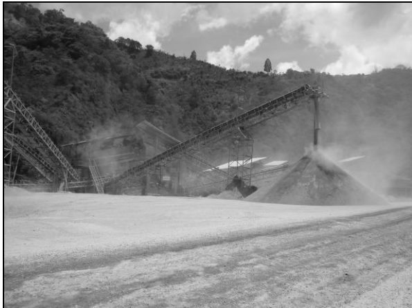
Foto 16. Triturador secundario en funcionamiento (etapa final de trabajo, 31 de marzo 2010)
