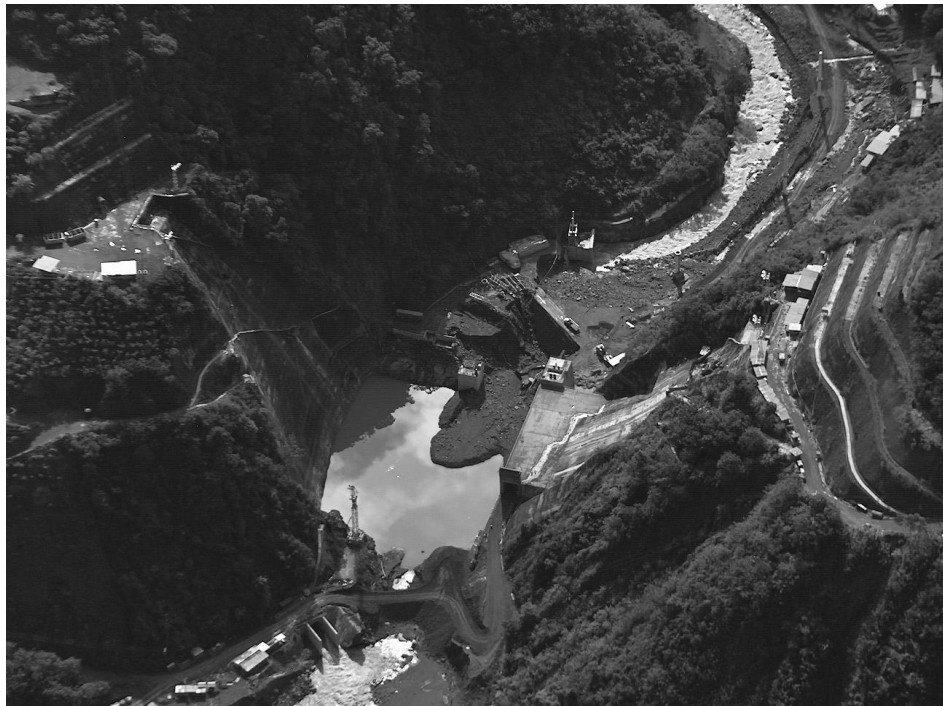
Foto 92. Dañados ocasionados por la tormenta Alma: recorrido aéreo realizado por Astaldi S. p. A. (Vista de la fundación de la presa, 8 de junio 2008
