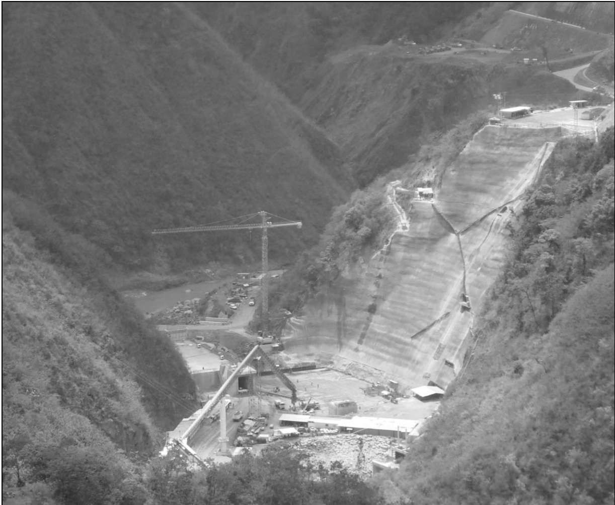
Foto 1. Condición inicial previa a la construcción de la presa, por parte del ICE, abril 2009
