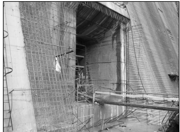
Foto 79. Entrada del ducto de la descarga de fondo, aguas arriba de la presa, octubre 2010
