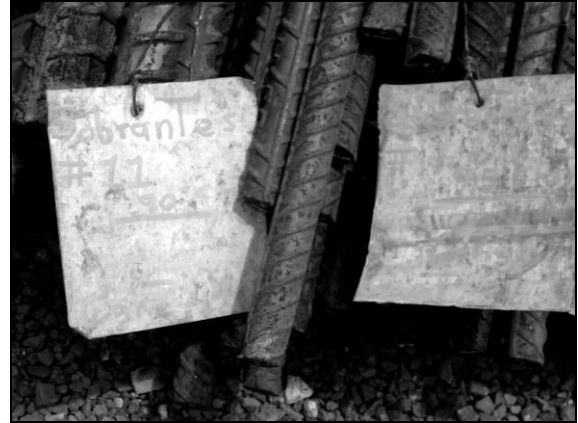
Foto 36. Clasificación de acero no estructural
