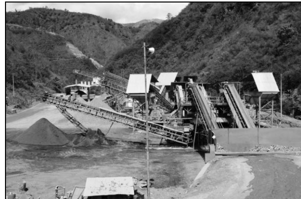
Foto 14. Triturador secundario, aguas arriba de la presa
