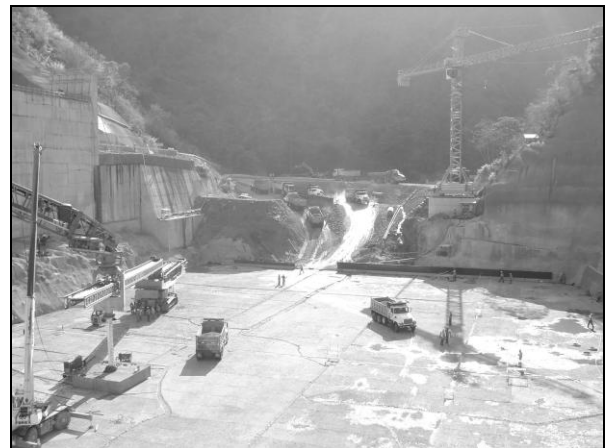
Foto 54. Simulacro de colocación de RCC con vagonetas cargadas con agregados, 19 de marzo del 2009 (4 días antes de iniciar el proceso de colocación de RCC)
