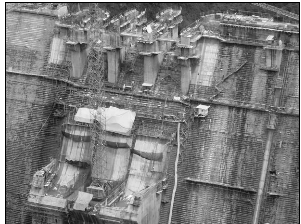
Foto 75. Losa y pilares del vertedor, aguas abajo de la presa, octubre 2010
