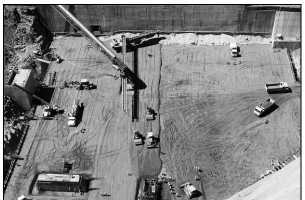
Foto 60. Planta de colocación de RCC, elevación 1101 msnm, abril 2009
