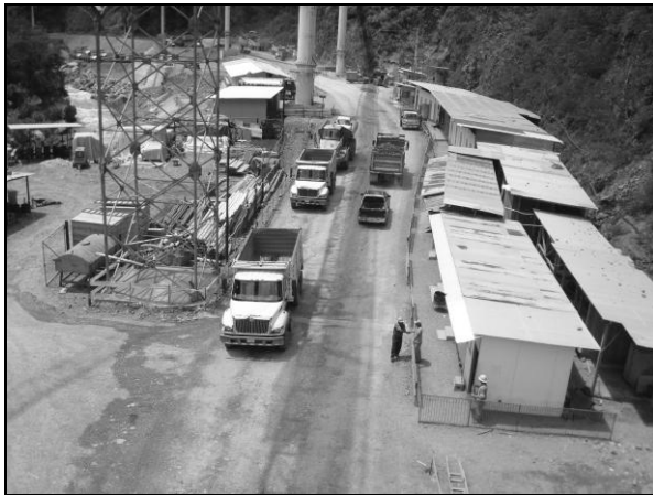
Foto 39. Instalaciones provisionales (oficinas y bodegas), aguas arriba de la presa
