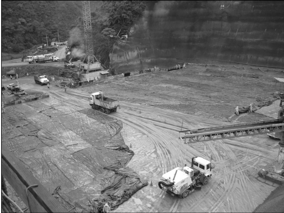
Foto 67. Protección de la capa de RCC, con plástico negro ante la caída de lluvia
