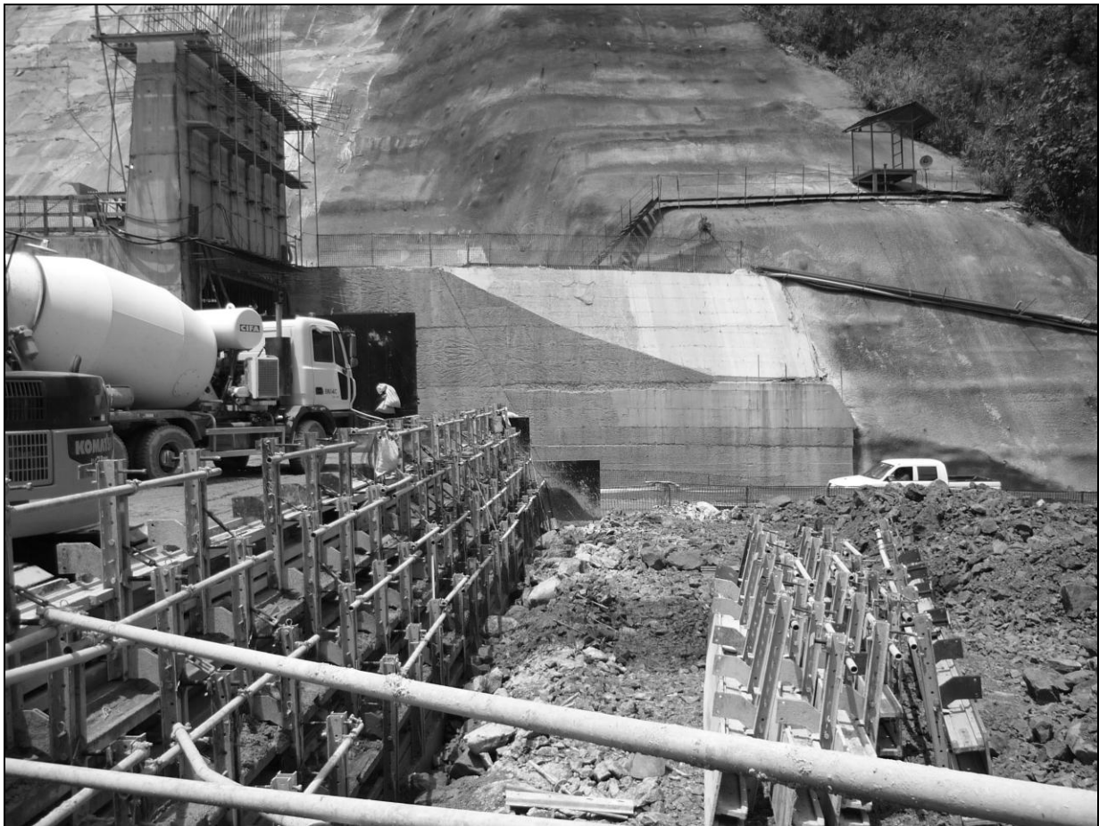
Foto 33. Formaleta instalada aguas abajo de la presa, así como formaleta ensamblada pendiente de colocar
