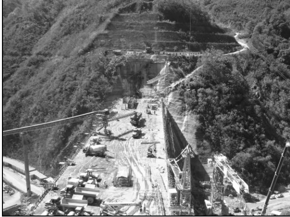
Foto 48. Reubicación de grúas torre Comedil y FM, vista margen derecha de la presa, febrero 2010
