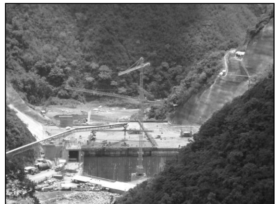
Foto 47. Grúas torre Comedil y FM, ubicadas aguas arriba y aguas abajo de la presa, agosto 2009
