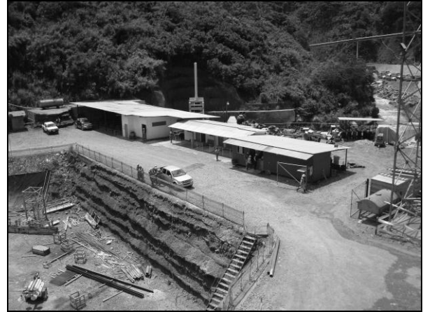
Foto 40. Instalaciones provisionales (comedor, dispensario y bodega de materiales), aguas arriba de la presa
