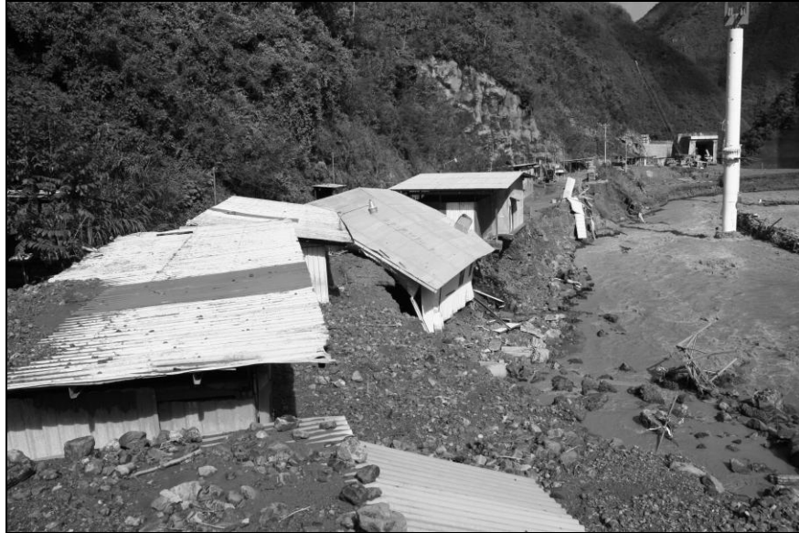
Foto 86. Instalaciones provisionales destruidas por deslizamientos, "Sitio Presa", 30 de mayo 2008
