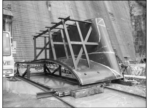
Foto 78. Embocadura de la descarga de fondo, aguas arriba de la presa, octubre 2010
