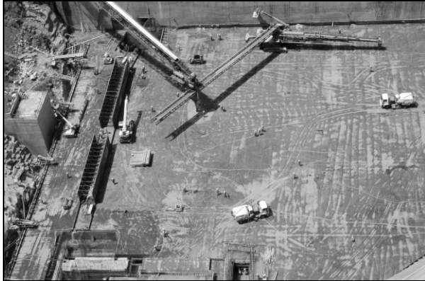
Foto 61. Construcción de galería de drenaje en la elevación 1105 msnm, mayo 2009
