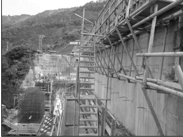
Foto 43. Escaleras de acceso a los concretos de cresta. Ver apéndice, plano de taller 009
