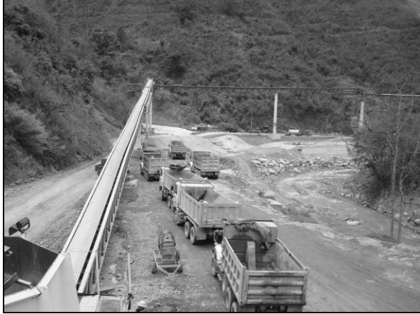
Foto 27. Salida de la banda transportadora de concreto en la planta de RCC, así como de las vagonetas que lo transportan
