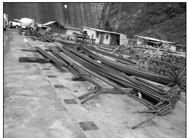
Foto 38. Entrega de acero doblado y etiquetado en la obra
