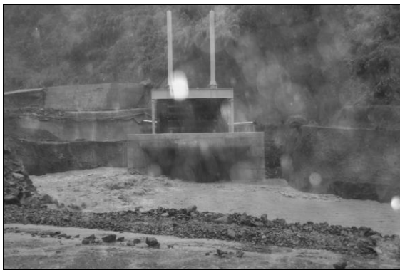
Foto 83. Estructura de entrada del túnel de desvío, a punto de llegar a su máxima capacidad, “Sitio Presa”, 29 de mayo 2008
