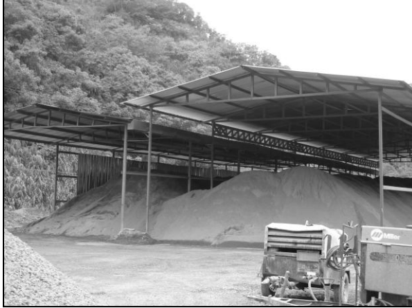
Foto 15. Galerones para la protección de la arena contra la lluvia, ubicado al lado del triturador secundario
