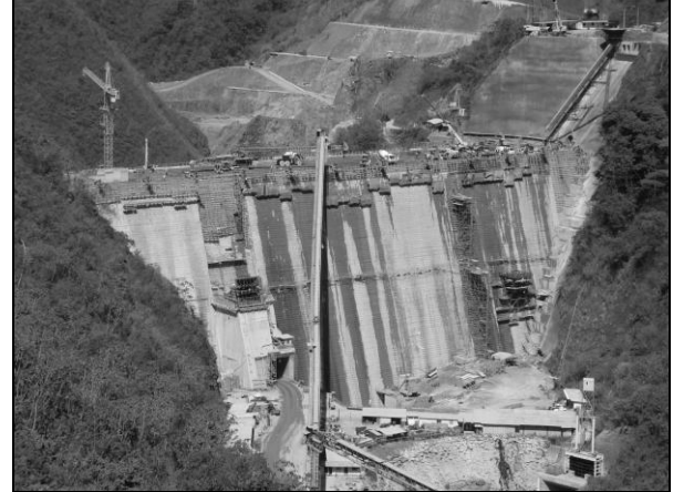
Foto 30. Inclinación de la banda transportadora, 11 de febrero, 2010
