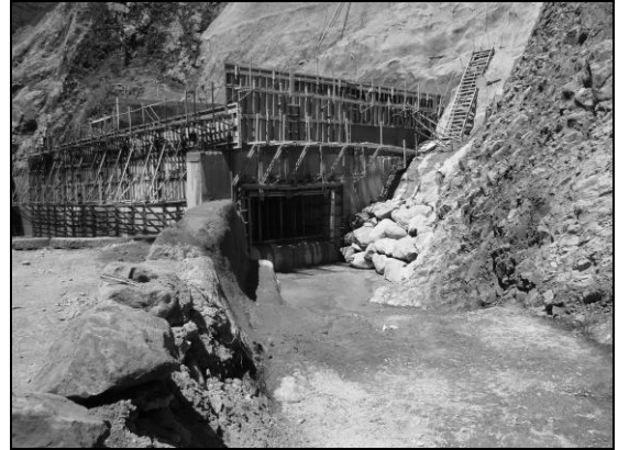
Foto 73. Desvío del río, a través de la descarga de fondo de la contra presa, febrero 2010
