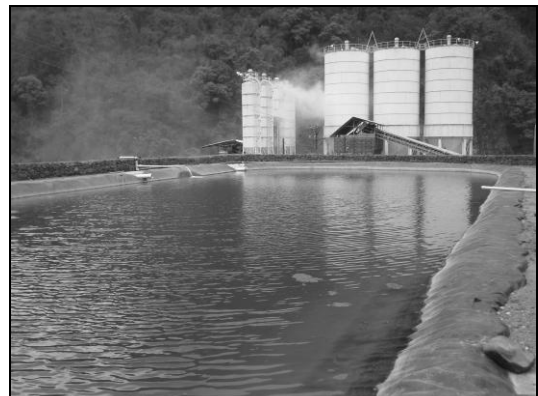
Foto 23. Piscina de almacenamiento de agua y silos de cemento, planta de RCC
