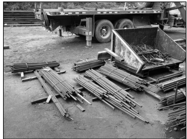
Foto 37. Clasificación por estructura de los sobranes, generados del corte y doblado de las piezas que aparecen en las cartillas de despiece
