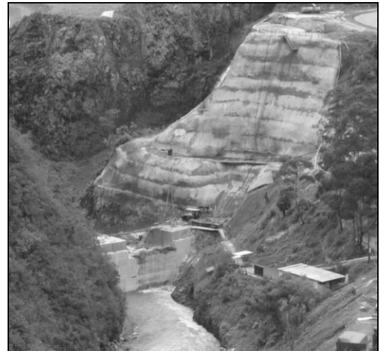
Foto 74. Bloque de fundación de la contra presa, setiembre 2010
