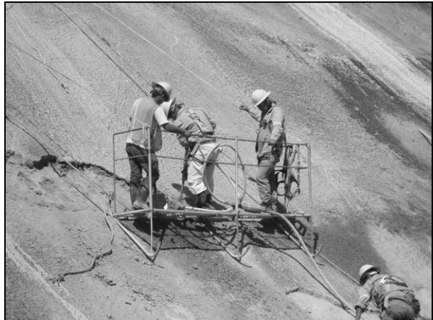
Foto 59. Reparación de de zonas dañadas, en la margen izquierda de la presa, junio 2009
