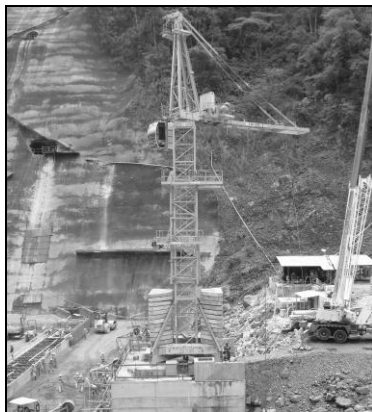
Foto 46. Instalación grúa torre FM, aguas arriba de la presa, mayo 2009
