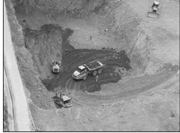
Foto 11. Aprovechamiento del tajo ya explotado, utilizado para colocar material de relleno (inicio), febrero 2010
