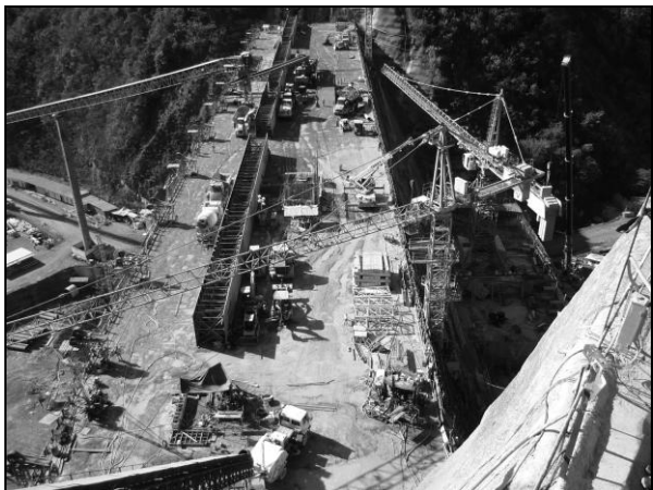
Foto 63. Construcción de galería de drenaje en la elevación 1175 msnm, febrero 2010
