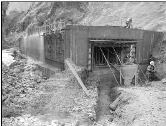
Foto 72. Construcción de la descarga de fondo de la contra presa, enero 2010
