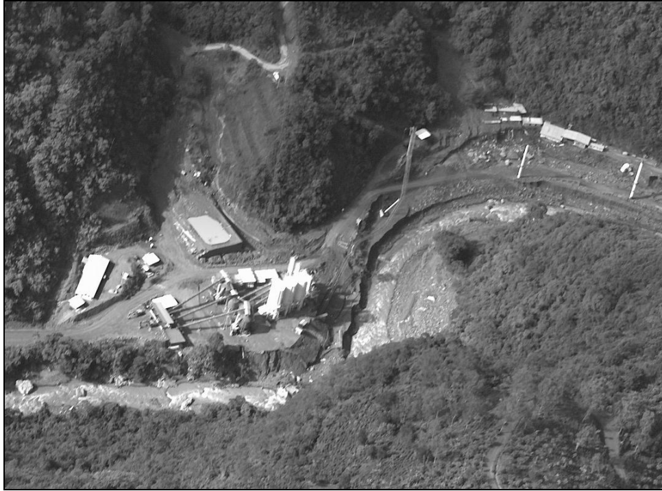
Foto 91. Dañados ocasionados por la tormenta Alma: recorrido aéreo realizado por Astaldi S. p. A. (Vista de la planta de RCC, "Sitio Presa", 8 de junio 2008
