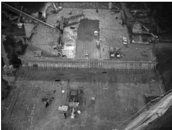
Foto 57. Colocación de RCC, mediante el sistema de construcción en híper bloque
