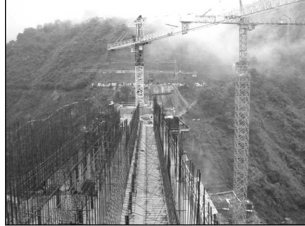
Foto 52. Interacción de grúas torre, zona de concretos de cresta de la presa, setiembre 2010
