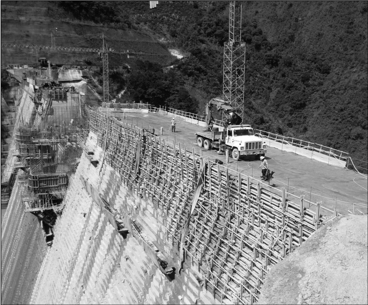
Foto 34. Paramento aguas abajo de la presa, con más de ocho gradas de 60 cm, encofradas
