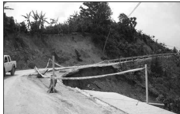
Foto 90. Tramos de carretera colapsada en la ruta de acarreo, San Carlos de Tarrazú, 30 de mayo 2008
