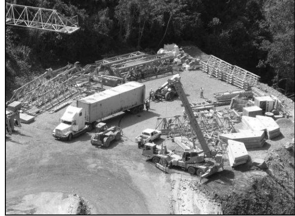
Foto 51. Plataforma de trabajo para pre armado de grúa torre POTAIN MD 1100
