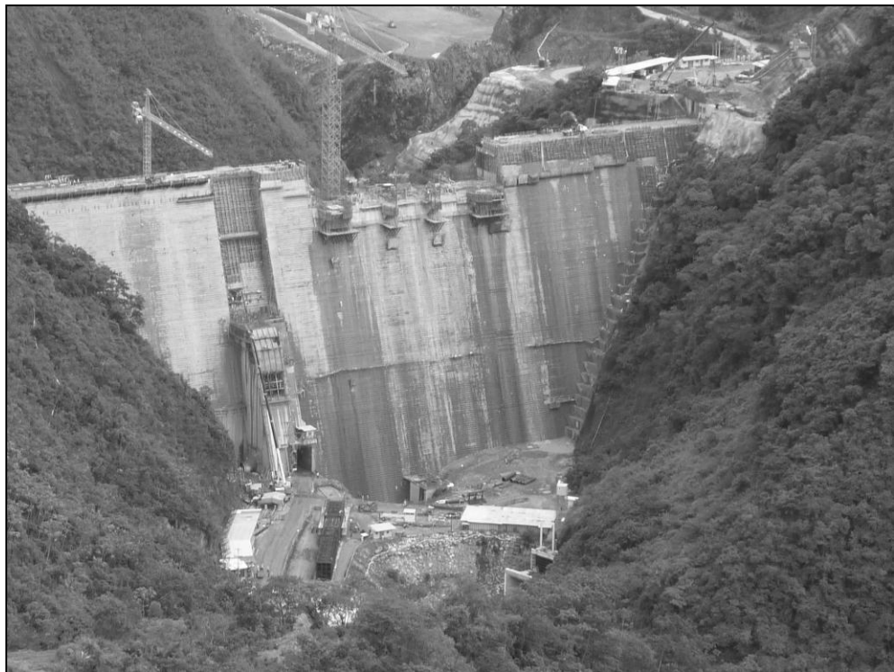
Foto 68. Vista aguas arriba de la presa, finalizado el proceso de colocación del RCC, 9 de junio 2010
