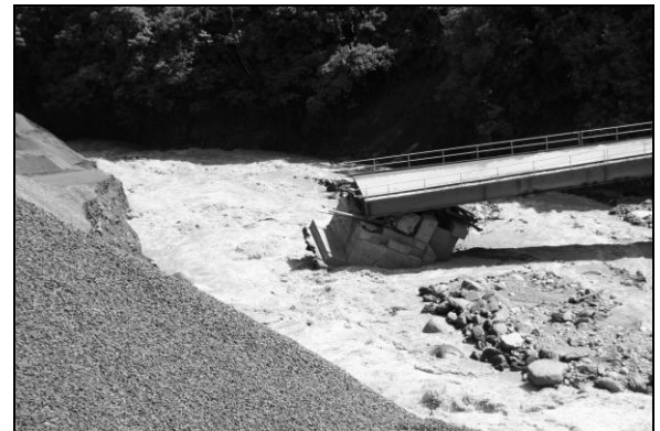
Foto 85. Colapso del puente principal en “Sitio Presa”, 30 de mayo 2008
