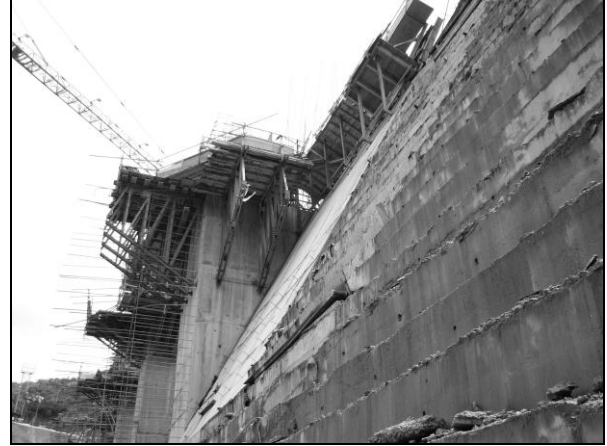
Foto 44. Plataformas de acceso a los pilares del vertedor. Ver apéndice, plano de taller 009
