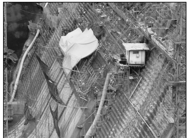
Foto 76. Construcción de la losa del vertedor, aguas abajo de la presa, octubre 2010
