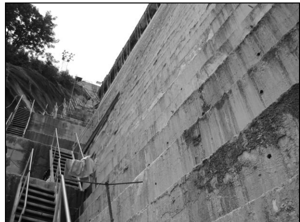
Foto 42. Escaleras de acceso a la margen izquierda de la presa, sobre los bloques de cierre
