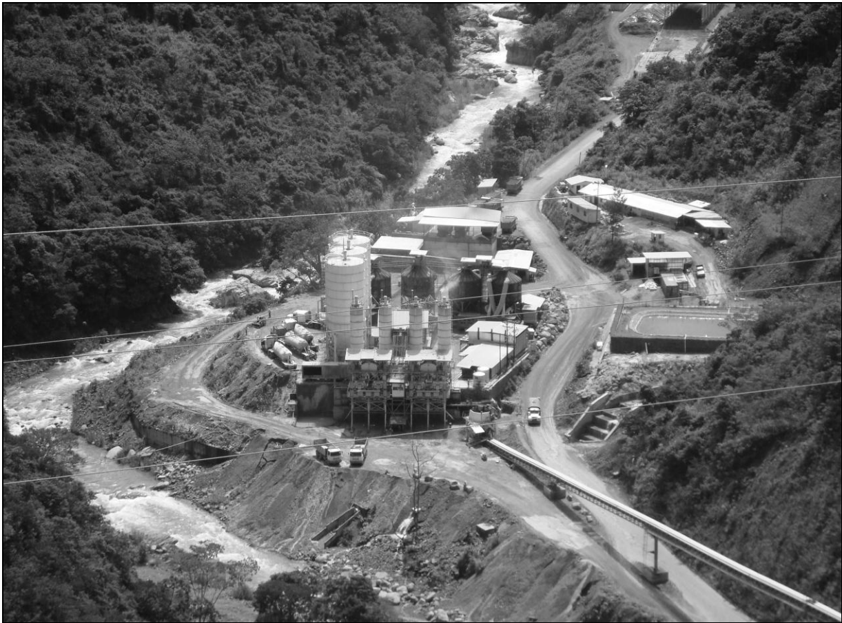
Foto 21. Planta de RCC, aguas arriba de la presa
