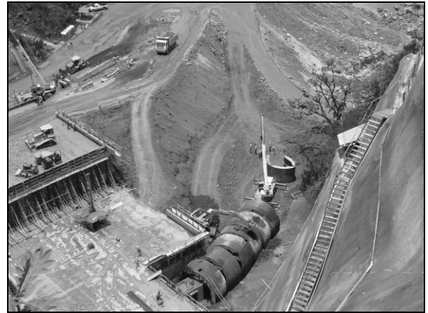
Foto 65. Conformación de la rampa de acceso aguas abajo de la presa, agosto 2009
