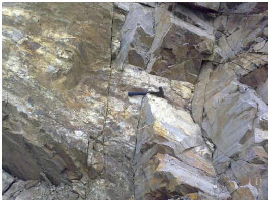
Figura 32. Ilustración de uno de los taludes analizados en el presente estudio. Fuente: Autora.
