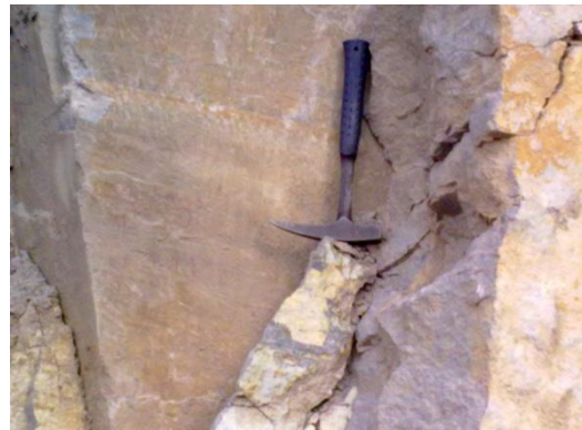
Figura 32. Talud donde analizado mediante el ensayo del Esclerómetro. Fuente: Autora.
