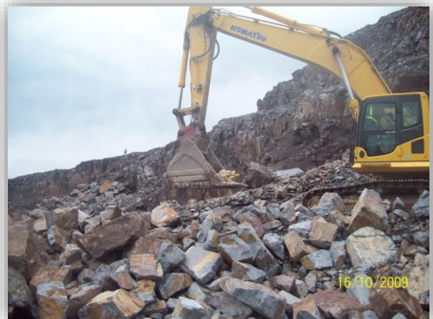
Figura 8. Material posterior a la voladura de una terraza Cerro Minas.
