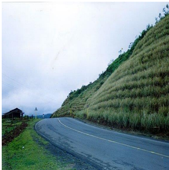
Figura 19. Refuerzo de un talud carretero con vetiver. (Ref. Internet # 5)
