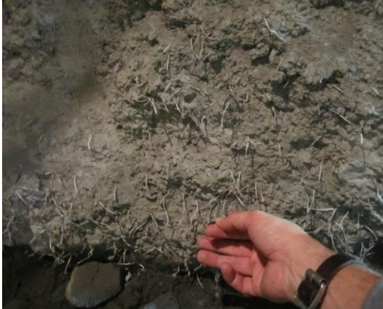
Figura 28. Foto del túnel Carretero en Reventazón, fibra sintética que se le añadirá al concreto lazando para sustituir malla electrosoldada
