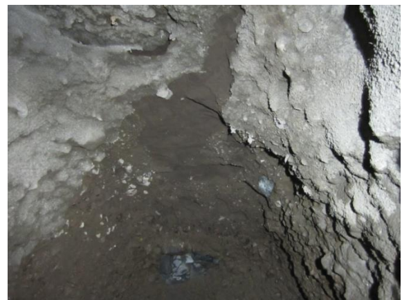
Figura 24. Foto del túnel Carretero en Reventazón, Roca Desnuda.
