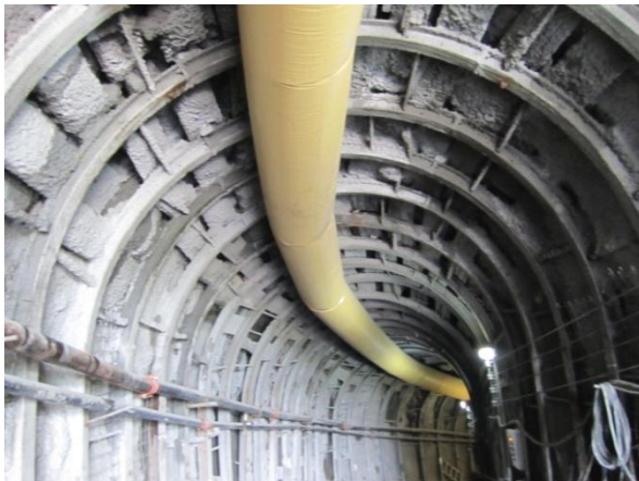
Figura 29. Foto del túnel Carretero en Reventazón, soporte temporal arcos de acero.
