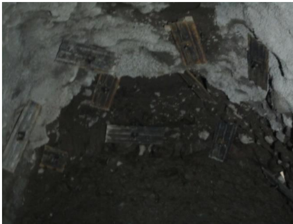
Figura 25. Foto del túnel Carretero en Reventazón, pernos puntuales.
