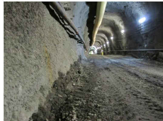
Figura 27. Foto del túnel Carretero en Reventazón, soporte concreto lanzado.
