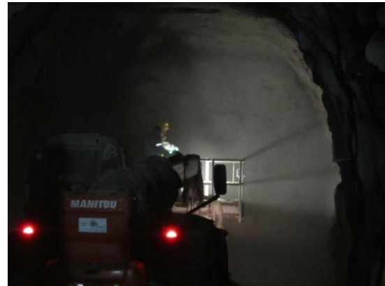
Figura 26. Foto del túnel Carretero en Reventazón, colocación de concreto lanzado.
