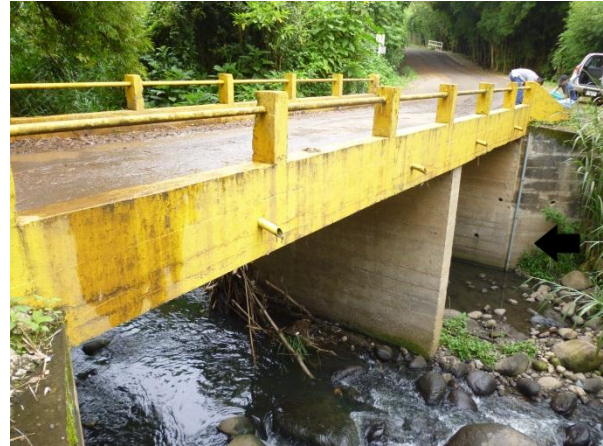
Figura 29. Vista general de la ubicación del sensor en uno de los bastiones del puente.
