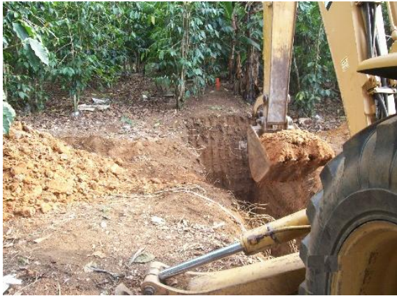
Figura 18. Extracción del material para realizar los ensayos en laboratorio, Sitio 01-Higuito de Desamparados
