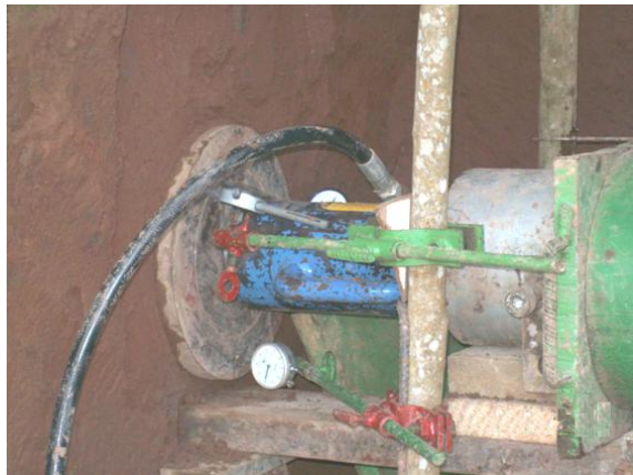
Figura 15. Equipo del ensayo de carga horizontal colocado en el nicho, Sitio 02-Puesto 07 P.H. Reventazón.
