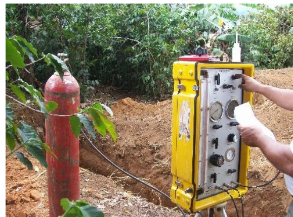
Figura 26. Ensayo con el presiómetro Menard para la determinación del módulo presiométrico y consecuentemente el módulo de elasticidad.
