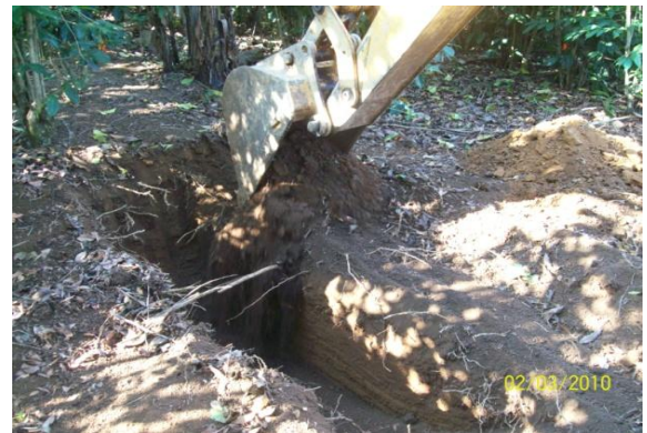
Figura 10. Trinchera conformada por el Back Hoe para realizar el ensayo.
