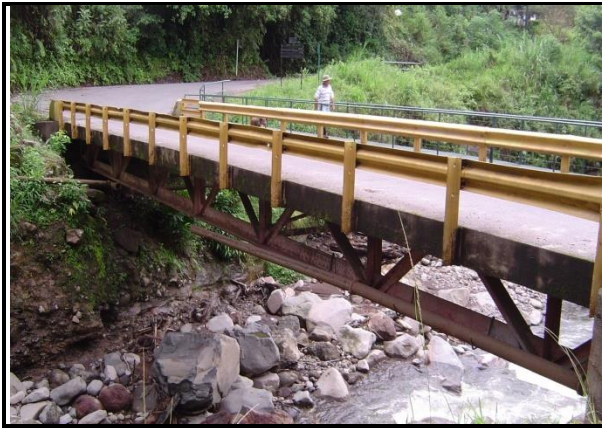
Figura 149. Vista general del puente sobre el Río Cariblanco.
