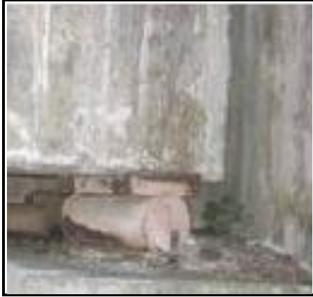
Figuras 1 y 2. Apoyo expansivo tipo patín y rodillo, respectivamente. (Fuente: Manual de Inspección de Puentes, 2007).
