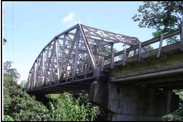
Figura 76. Vista panorámica del puente sobre el Río Toro.
