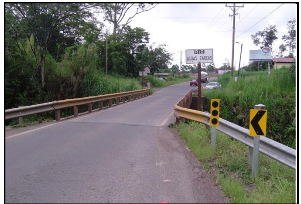
Figura 58. Vista general del puente sobre Río Aguas Zarcas.
