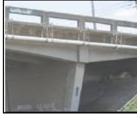
Figura 4. Apoyo rígido. (Fuente: Manual de Inspección de Puentes, 2007)
