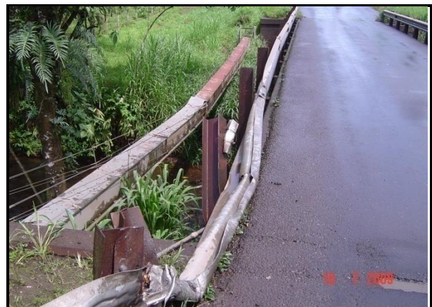
Figura 87. Deformación de las barandas flexbeam.
