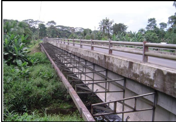
Figura 118. Vista lateral de la estructura
