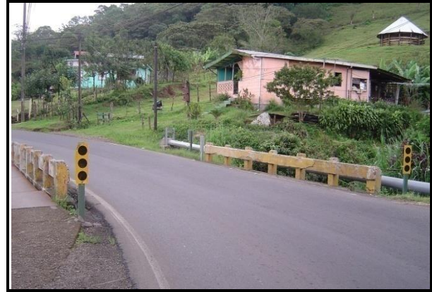
Figura 33. Vista panorámica del Puente sobre Río Marín.
