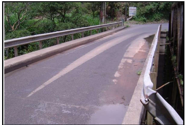
Figura 138. Vista general del puente sobre el Río Peje
