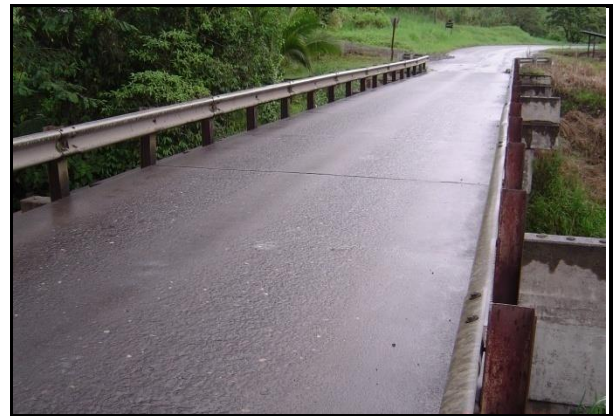
Figura 47. Vista panorámica del Puentes sobre Río Sardinal.
