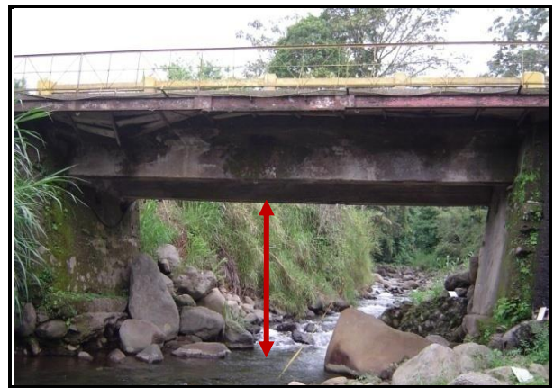
Figura 53. Detalle del claro hidráulico
