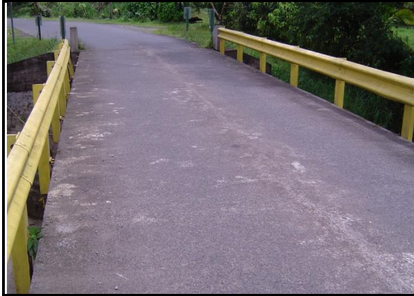
Figura 153. Vista general del puente sobre el Río María Aguilar.
