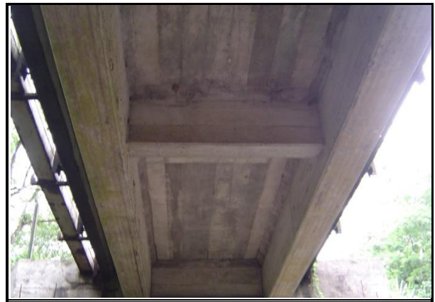
Figura 21. Vista inferior del Puente sobre Río San Rafael.
