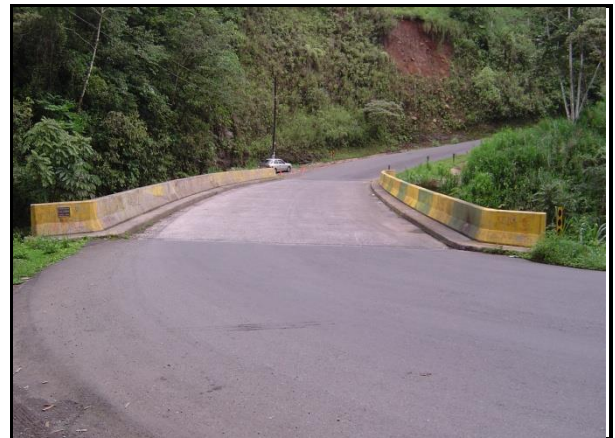
Figura 133. Vista general del puente sobre el Río La Vieja.
