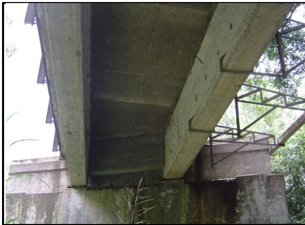
Figura 89. Vista inferior, detalle de las vigas de concreto.
