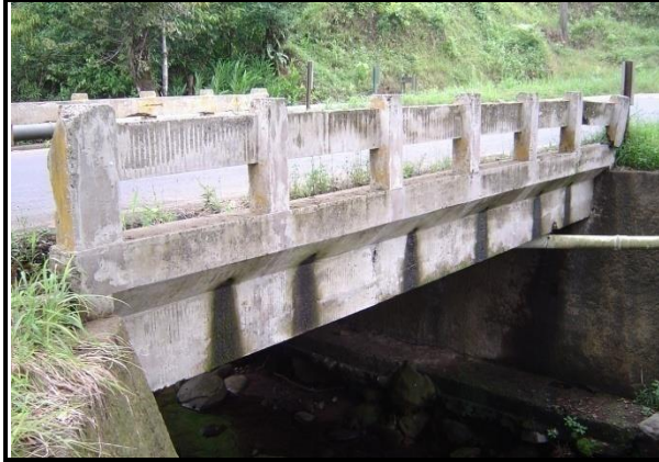
Figura 26. Vista panorámica del puente sobre el Río Leones.
