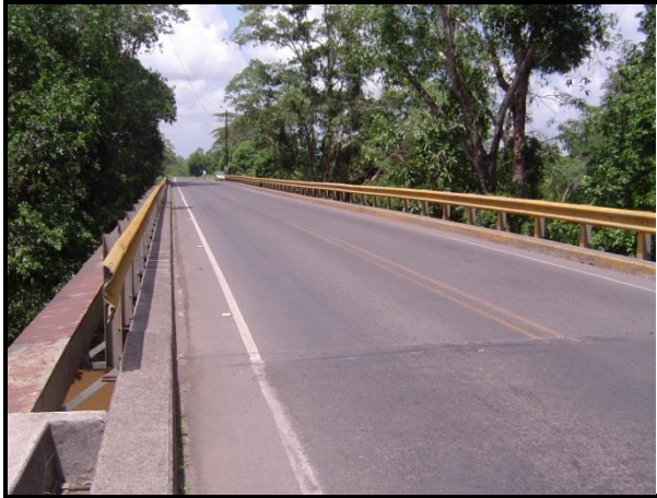
Figura 121. Vista general del puente sobre el Río Sarapiquí.
