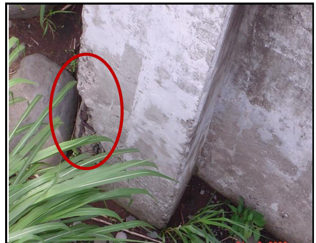
Figura 67. Detalle del acero principal y transversal expuesto en la pila.
