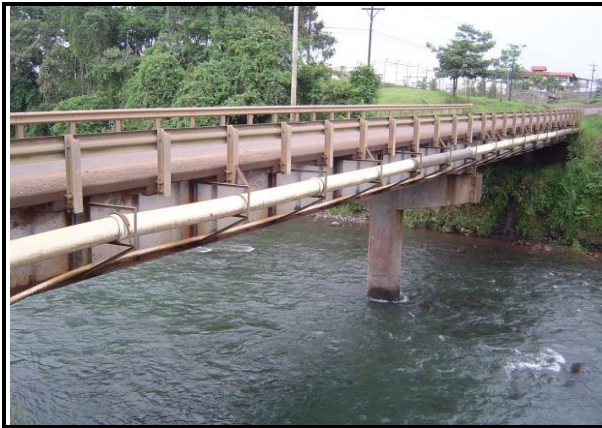
Figura 163. Vista Lateral del puente.
