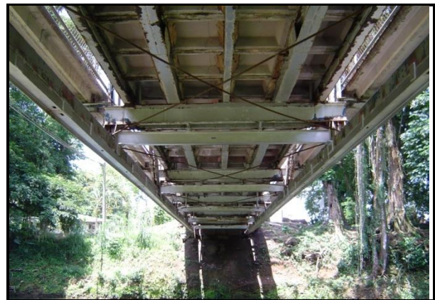
Figura 144. Vista inferior del puente.
