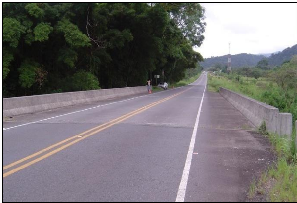
Figura 103. Vista panorámica del puente sobre Río Brazo del Sucio.
