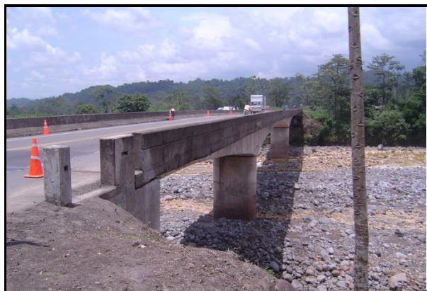
Figura 96. Vista panorámica del puente sobre el Río Chirripó.
