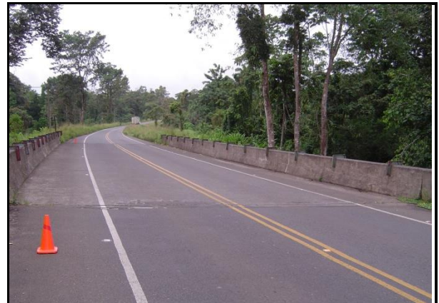
Figura 113. Vista panorámica del puente sobre el Río Isla Grande.
