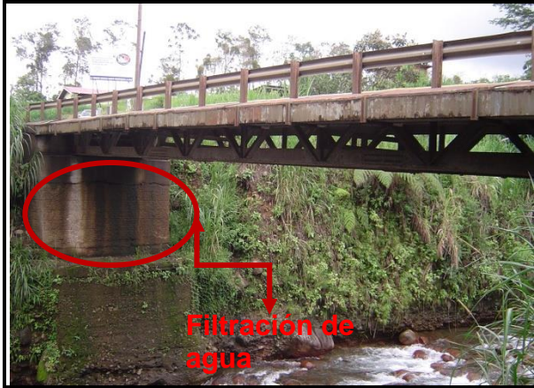
Figura 59. Vista lateral de la estructura, representación de las cerchas de paso inferior.
