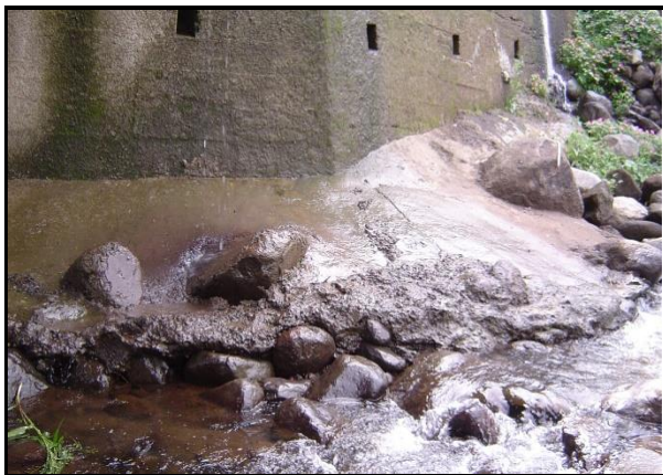
Figura 81. Detalle del estado del bastión luego de l reforzamiento.
