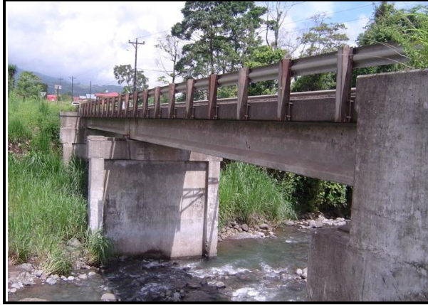
Figura 63. Vista general del puente sobre Río Guayabo
