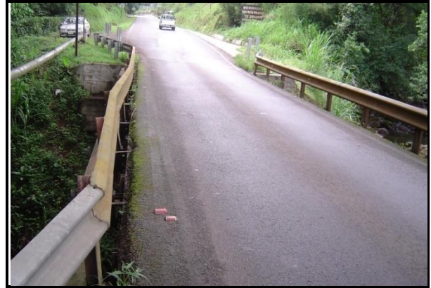
Figura 20. Vista panorámica del Puente sobre Río San Rafael.
