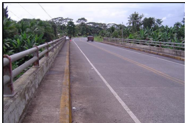
Figura 117. Vista general del puente sobre Río Tigre.
