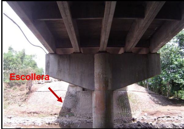
Figura 110. Vista inferior, detalle de escollera en uno de los bastiones.
