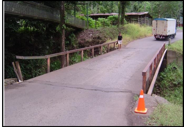
Figura 158. Vista general del puente sobre Quebrada Grande.
