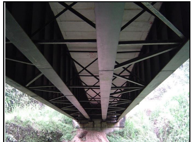
Figura 134. Vista inferior de la estructura del puente, representando las vigas de acero y el sistema de arriostramiento.
