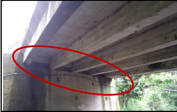
Figura 39. Vista inferior, señalando el método de apoyo de las vigas de concreto.
