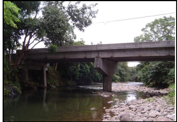
Figura 108. Vista lateral del puente sobre Río San José.
