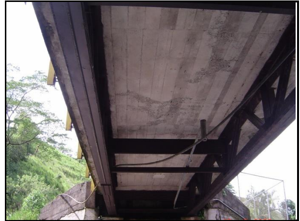
Figura 155. Vista inferior, detalle de las cerchas.
