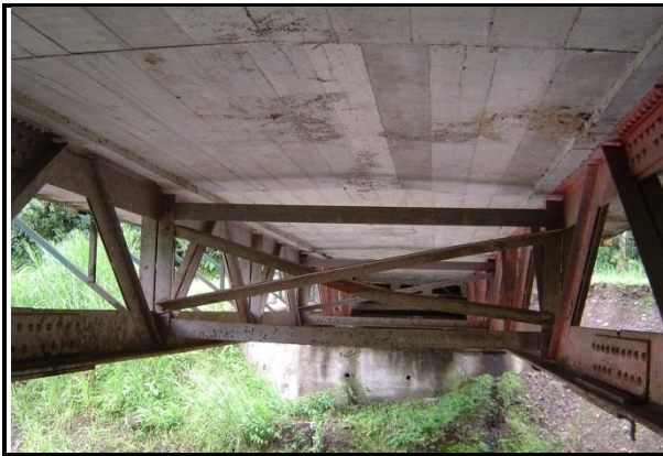
Figura 150. Vista inferior del puente.
