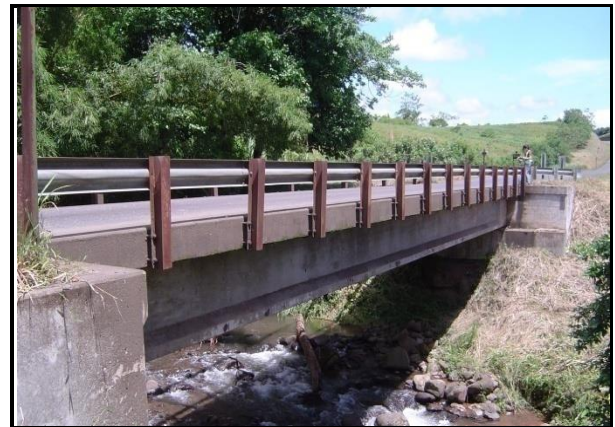
Figura 90. Vista lateral del puente sobre Río Hule.
