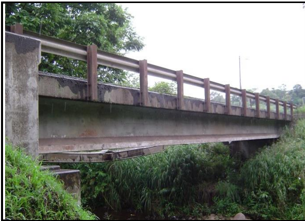
Figura 84. Vista lateral del Puente sobre Río Cuarto.
