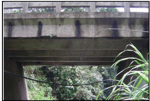
Figura 14. Vista lateral del puente sobre el Río Ceiba.
