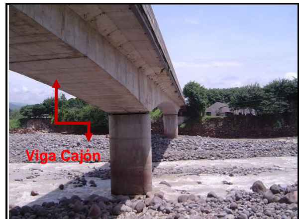
Figura 97. Vista inferior, detalle de la viga cajón
