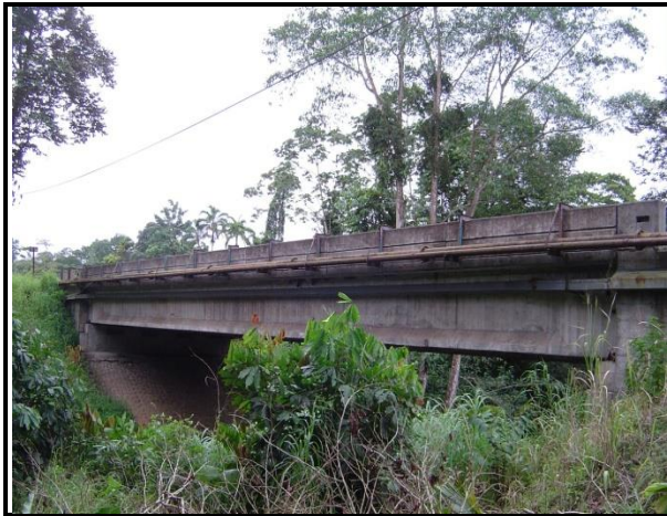
Figura 114. Vista lateral del puente.
