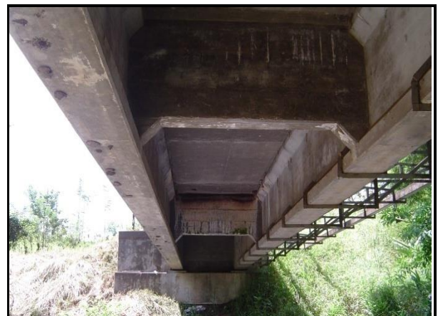
Figura 91. Vista inferior, detalle de las vigas de concreto.
