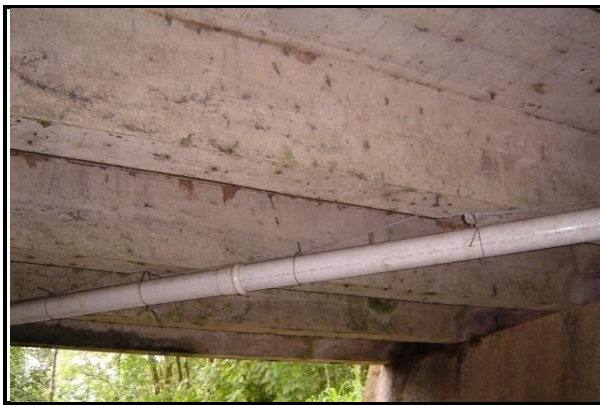
Figura 27. Vista lateral del estado del puente.
