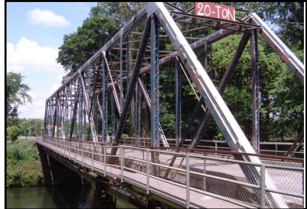
Figura 143. Vista general del puente sobre el Río San José.
