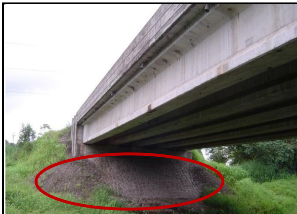
Figura 104. Vista lateral del puente sobre Río Brazo del Sucio, y detalle de la escollera.
