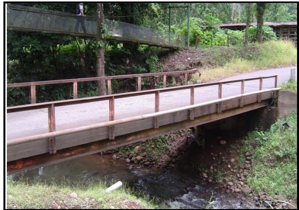
Figura 159. Vista lateral de la estructura.
