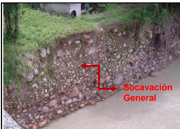
Figura 100. Problema de socavación general en las márgenes del río.
