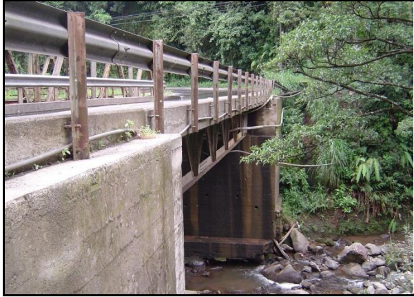
Figura 139. Vista lateral de la estructura.
