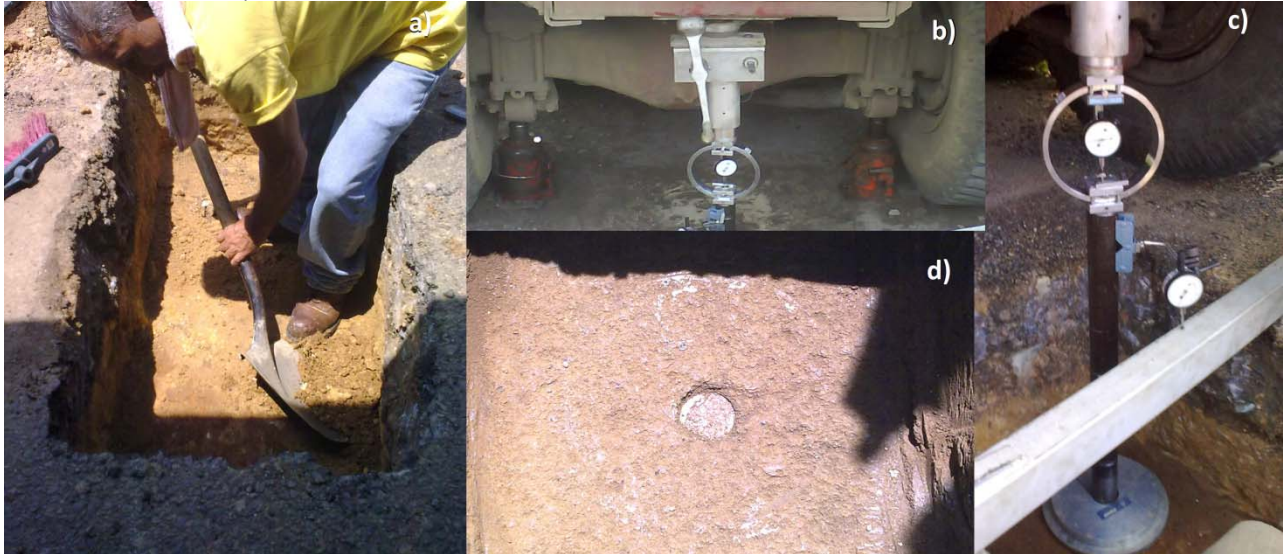
Figura 13M. Proceso de la prueba de CBR, a) Escavar, nivelar la sub-rasante, b) Colocar el camión y ponerle las gatas, c) Colocar el equipo de CBR y los relojes en cero y d) Fallar la estructura y tomar las lecturas.
