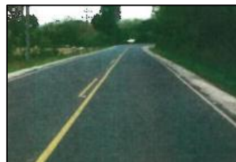
Fig.65. Intervención de agrietamiento, Ruta 18.
