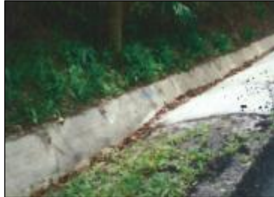
Fig.13 y 14. Vegetación en contacto con cuneta y pavimento. San Isidro del General.
