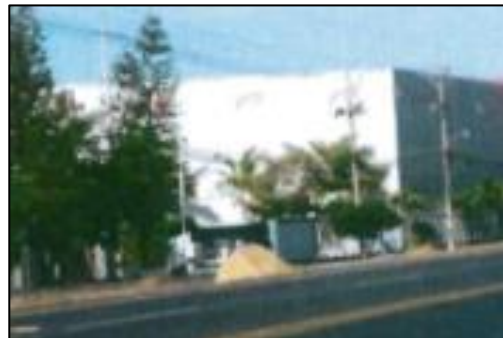
Fig.85. Vista general de carpeta asfáltica, ruta nacional.
