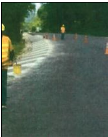
Fig.64. Revestimiento de espaldones, Ruta 160.
