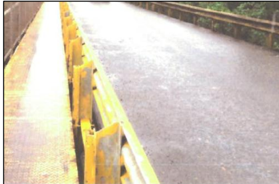
Fig. 100. Demarcación horizontal y accesos adecuados.
