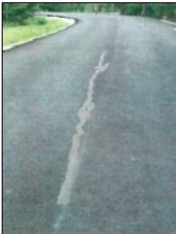
Fig. 62. Sellado de grietas, Ruta 160.
