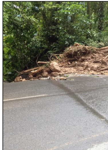
Fig. 154. Presencia de agua en la vía.
