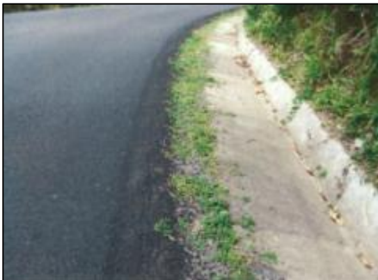
Fig.13 y 14. Vegetación en contacto con cuneta y pavimento. San Isidro del General.
