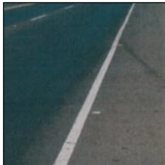
Fig.84. Carpeta asfáltica de la ruta nacional 1.
