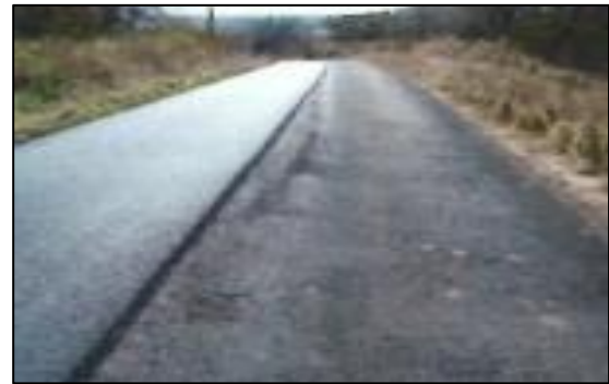
Fig.18. Colocación de sobrecapa en ruta 917.
