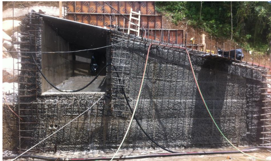
Figura 15. Toma de aguas terminada con acero expuesto para amarre con Muro Aleton Derecho.
