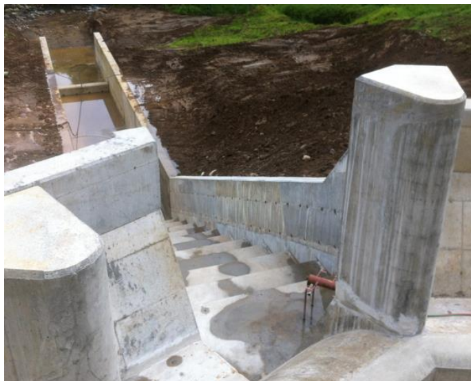
Figura 19. Disipador y Canal de restitución de la Cámara de Carga. Tomada el 14 de Septiembre de 2012.
