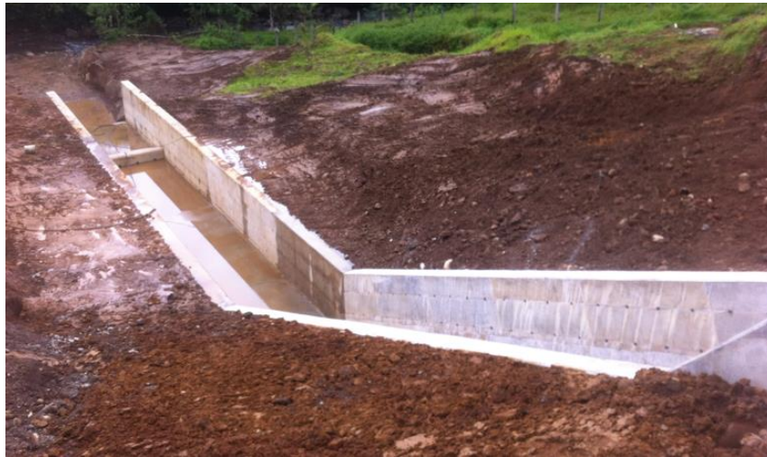
Figura 18. Cana de restitución de la Cámara de Carga. Tomada el 14 de Septiembre de 2012.
