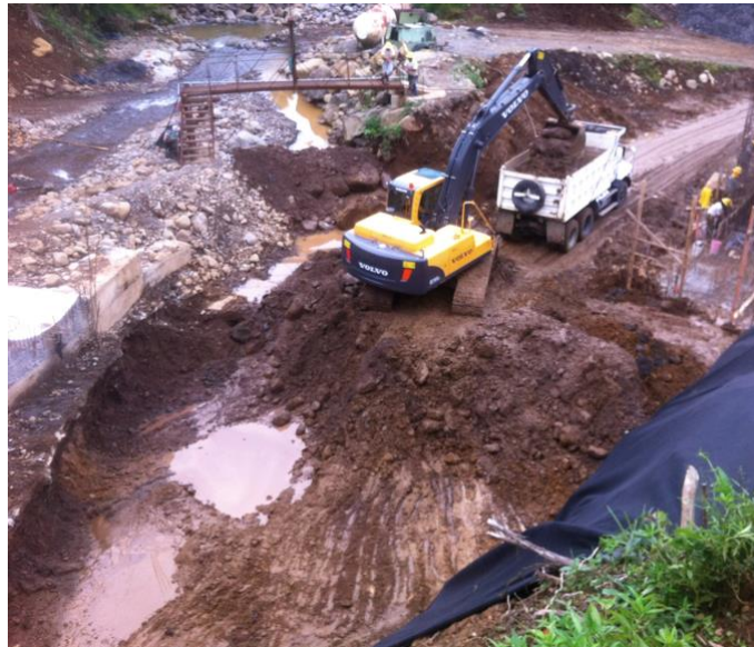
Figura 7. Sustitución de Suelo para construcción de desarenador en etapa de movimiento de tierra.
