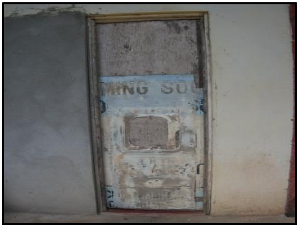
Figura 3. Puerta posterior, vista exterior.
