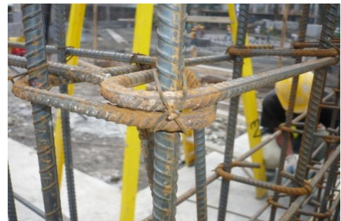
Figura 35. Amarras simples y dobles en la armadura de columnas y vigas. (Fuente: Ingeniería, Recope)
