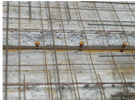
Figura 31. Soportes en la colocación de armadura. (Fuente: Ingeniería, Recope)
