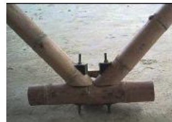
Figura 8 . Unión Simón Vélez (Fuente: Jaramillo y Sanclemente, 2003)
