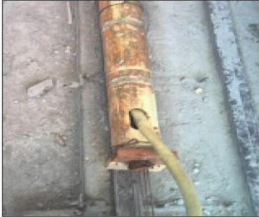
Figura 6. Perforación del bambú para relleno de mortero (Fuente: Peña y Rodríguez, 1997) 2
