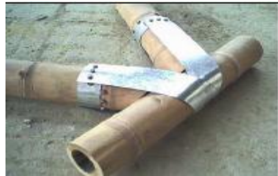
Figura 12. Unión Sandra Clavijo. (Fuente: Jaramillo y Sanclemente, 2003)
