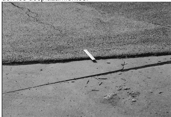
Figura 13. Desplazamiento de severidad media. Fuente: (ASTM, 2014)
