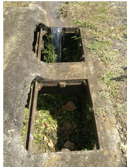
Figura 39. Tragantes sin rejillas en Calle Conector Rosales-Cootaxa.
