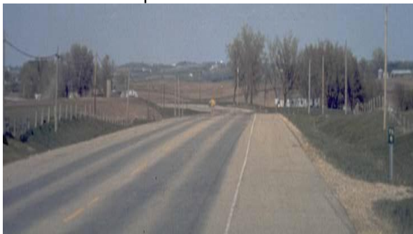
Figura 17. Exudación de severidad alta. Fuente: (Castro, 2013)
