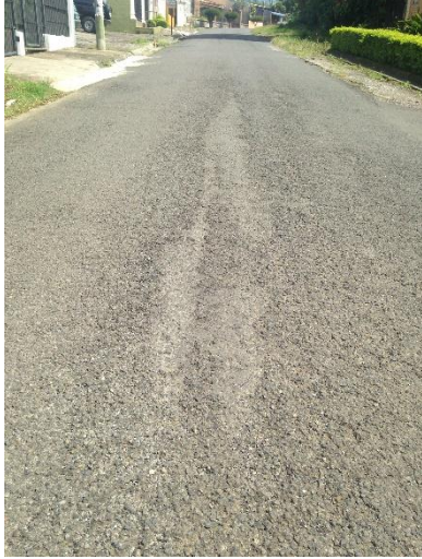
Figura 16. Peladura por intemperismo de severidad alta. Fuente: Elaboración propia del autor.
