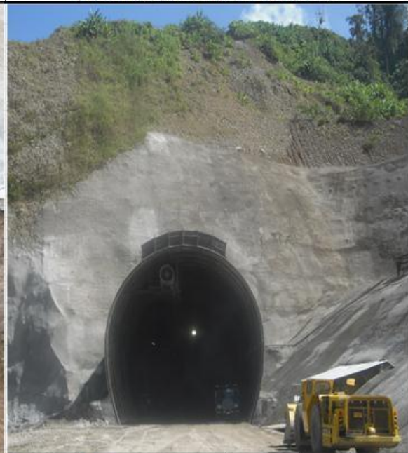
Fotografía 12. Excavación de la sección completa en el inicio de túnel de la descarga de fondo
