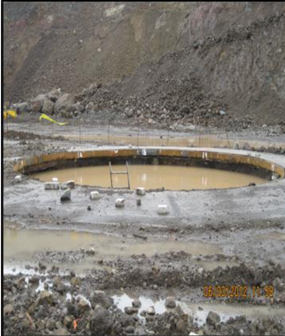
Fotografía 1. Inicio de la excavación del pozo vertical
