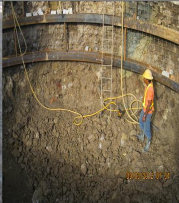
Fotografía 4. Primeros metros del pozo excavado en brecha
