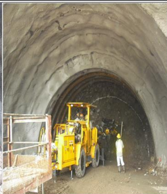
Fotografía 10. Excavación del frente del túnel, realizando perforaciones para la colocación de explosivos
