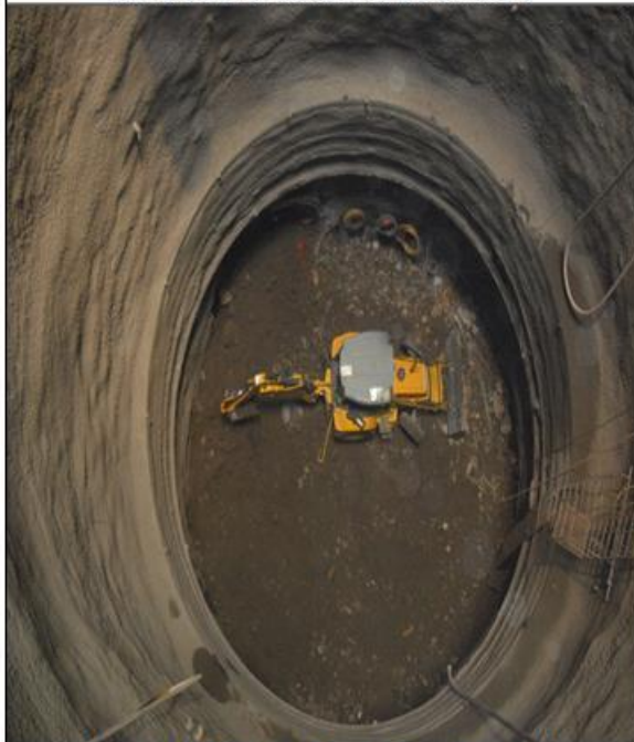
Fotografía 7. Primera etapa de la excavación concluida, elevación: 220 m.s.n.m
