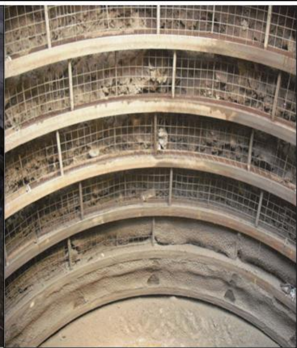
Fotografía 6. Soporte listo para ser revestido de concreto
