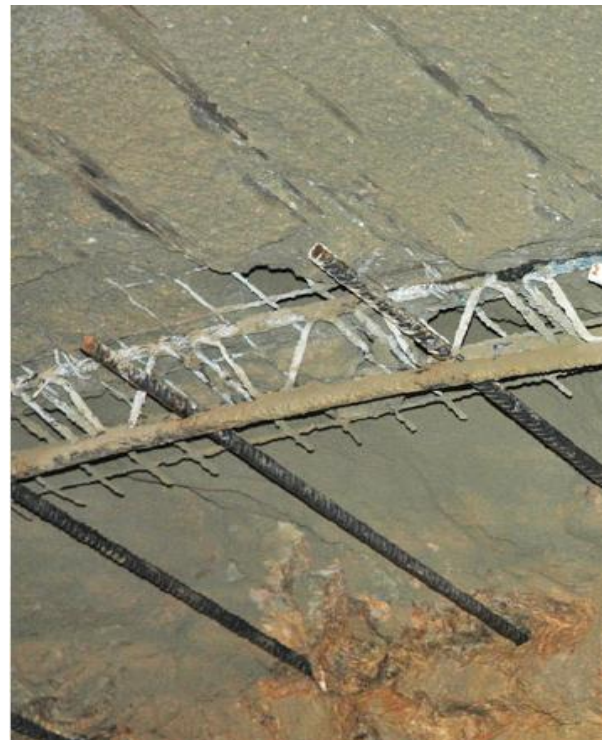
Figura 30. Instalación de cercha reticular en el frente del túnel
