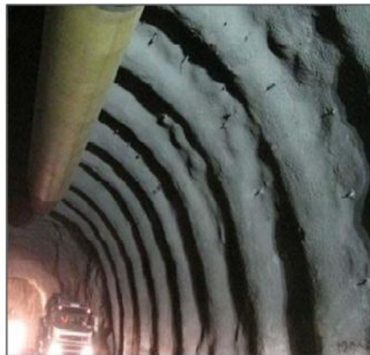
Fotografía 4. Revestimiento final de
