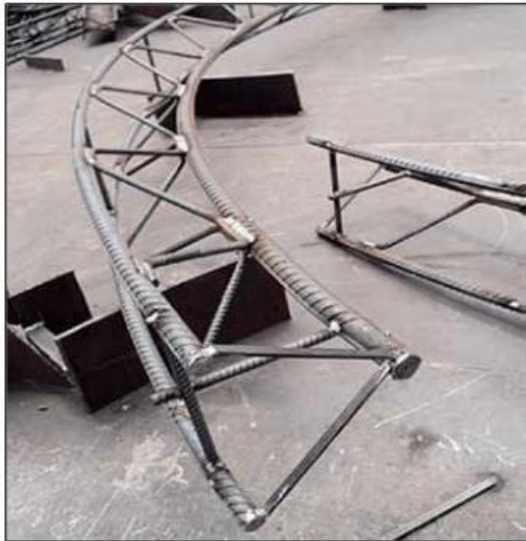
Fotografía 1. Fabricación de la cercha
