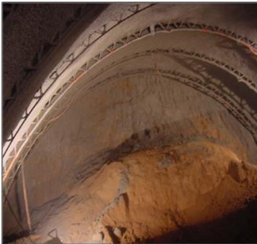
Fotografía 3. Estabilización del frente
