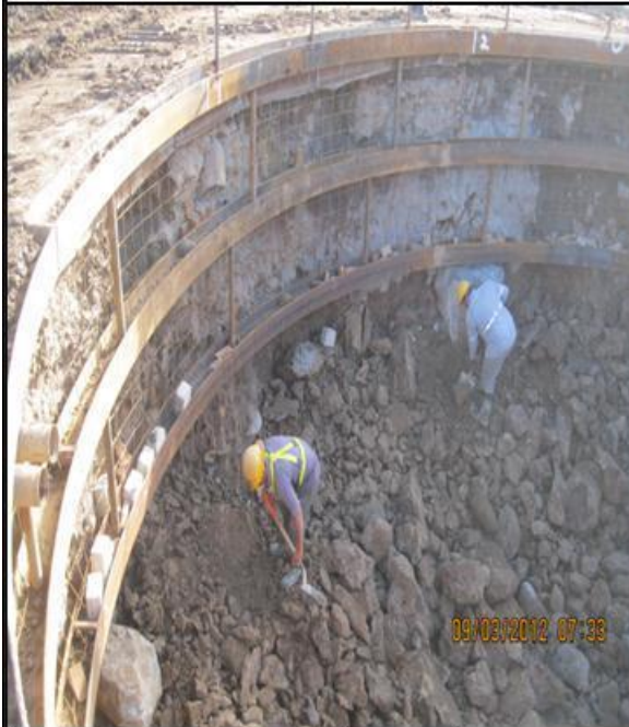
Fotografía 3. Limpieza final de tramo para continuar la excavación
