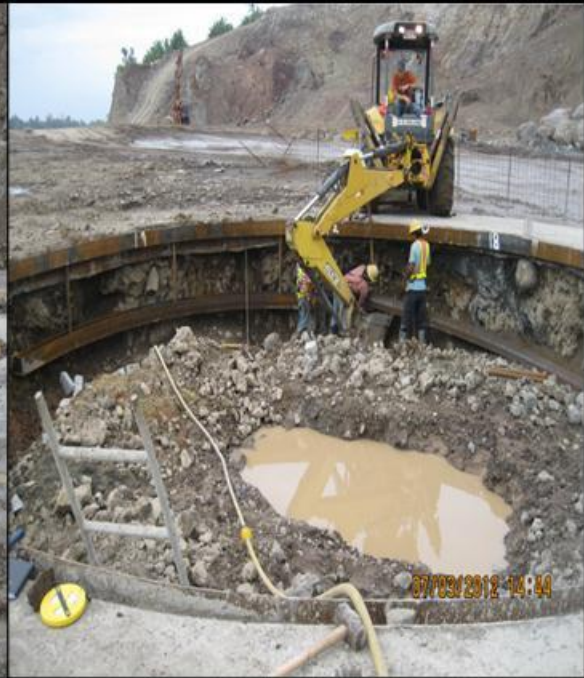
Fotografía 2. Colocación del soporte temporal (viga w&x31)
