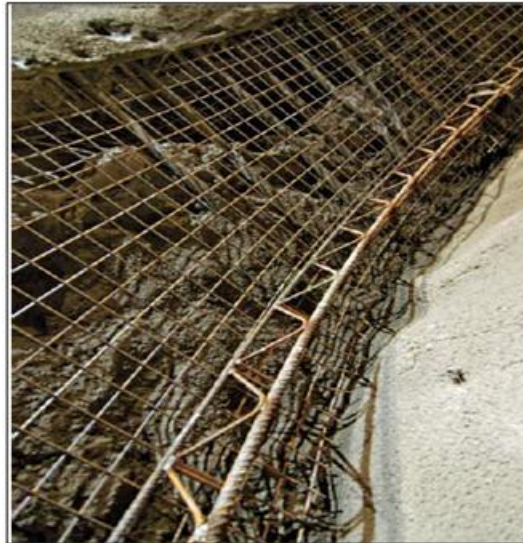
Fotografía 2. Colocación del soporte en el
