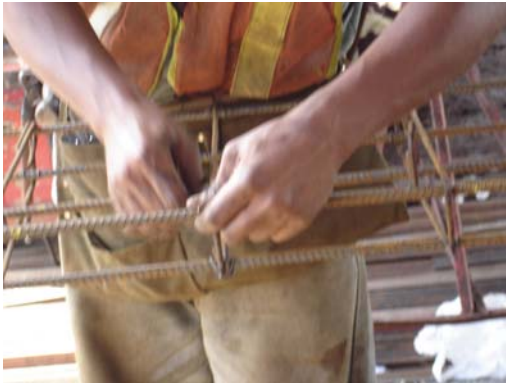
Figura 7. Confección de armadura
