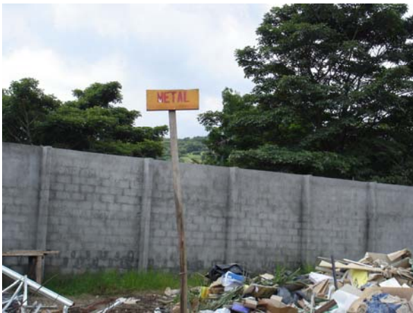
Figura 4. Área señalada para desechos de metal
