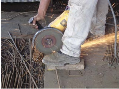
Figura 6. Corte de varillas para armadura
