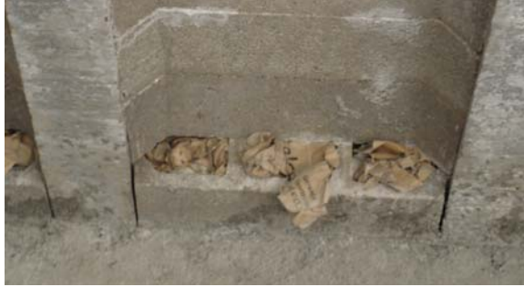
Figura 25. Reutilización de sacos de empaque en la actividad de chorrea de entrepiso
