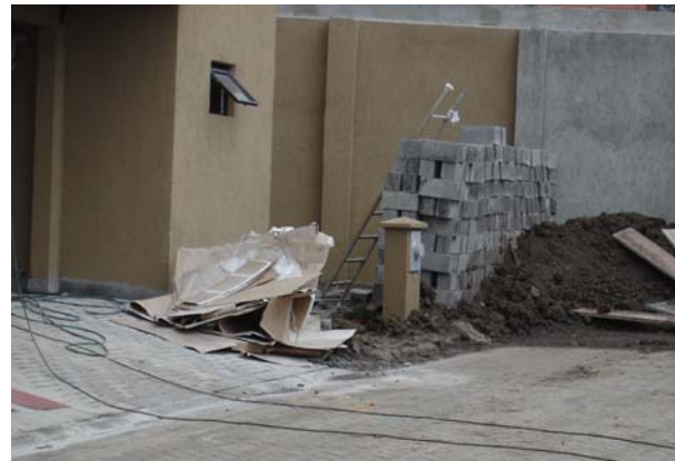
Figura 2. Desechos colocados en las afueras de las unidades del condominio
