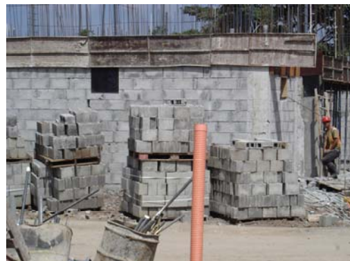
Figura 15. Formaleta de viga de entrepiso
