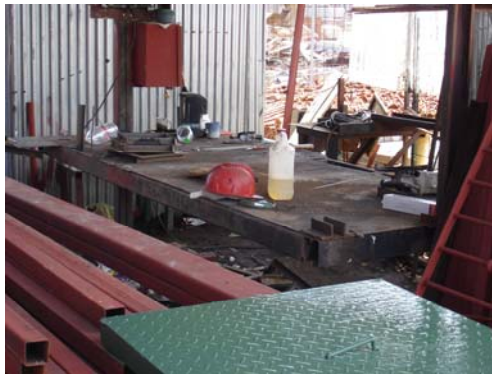
Figura 11. Taller de Soldadura
