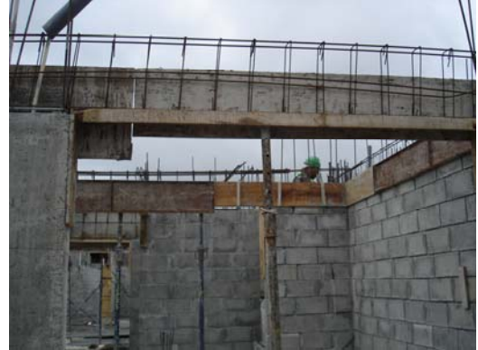
Figura 9. Armadura de viga de entrepiso
