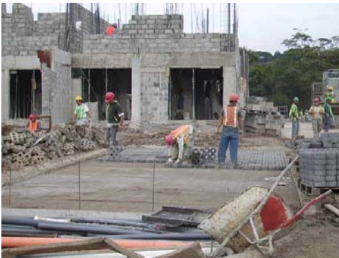
Figura 27. Construcción zona de parqueos
