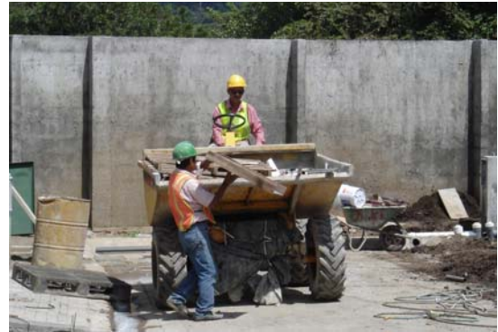
Figura 29. Recolección de residuos empleando volquete
