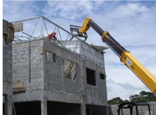
Figura 18. Colocación de estructura de techo y tapicheles
