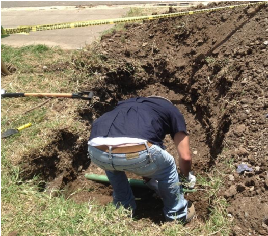
Imagen 5. Trabajos de excavación en Escuela de Producción Industrial, edificio de oficinas.
