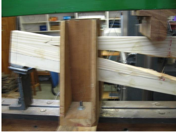
Detalle de falla por tensión en el espécimen VS4. La grieta se propaga hacia uno de los apoyos.
