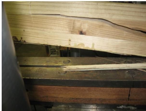
Falla de la viga VRG.
