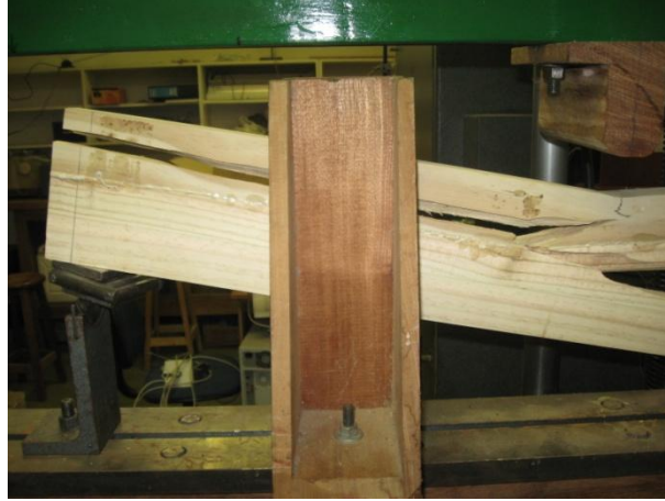
Detalle de falla por cortante en el espécimen VS5. Propagación de la grieta.
