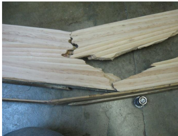
Falla a tensión del refuerzo.
