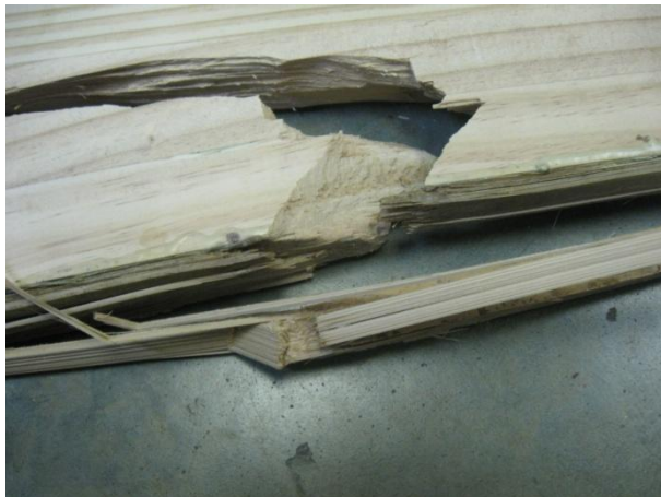
Vista lateral de la falla. Se aprecia el rompimiento
