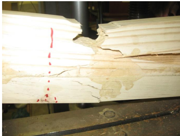
Detalle de la falla por cortante del espécimen VS10. La grieta se propaga hasta el bloque de carga derecho.
