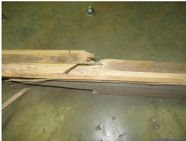
Falla a tensión del refuerzo.
