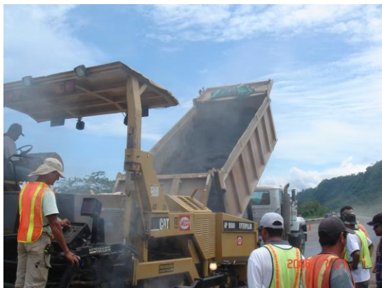
Figura 8. Elaboración del paño de prueba de la mezcla modificada con látex UP70SBR.
