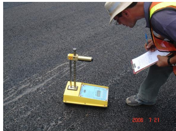
Figura 11. Toma de la densidad en sitio de la mezcla asfáltica con látex UP70SBR.
