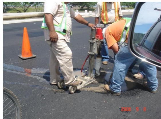
Figura 12. Extracción de núcleos en la carpeta asfáltica realizada con la mezcla modificada.
