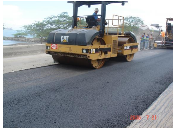
Figura 10. Proceso de compactación de la mezcla asfáltica con látex UP70SBR.
