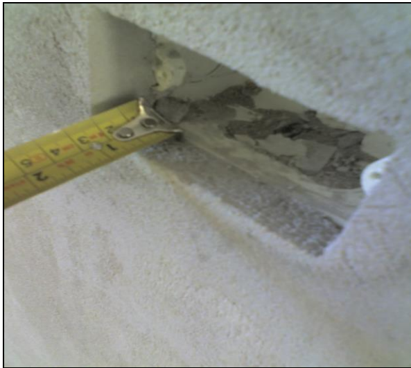
Fotografía 4.6 Repello Grueso en pared
