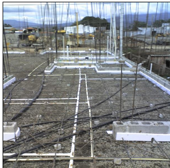
Fotografía 4.5 Tuberías Potables en contrapiso antes de chorrear
