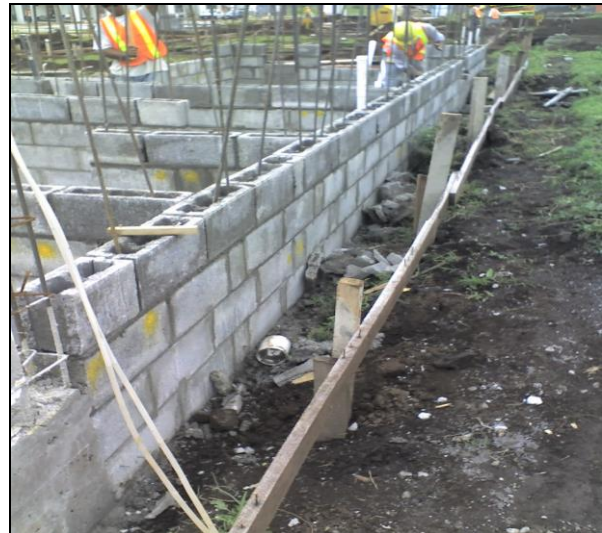
Fotografía 1.7 Levantamiento de paredes de bloques
