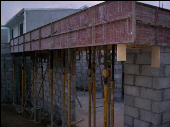
Fotografía 1.8 Levantamiento de paredes de bloques
