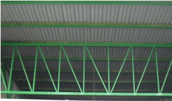
Figura 1. Estructura de techo compuesta de perfiles tipo C. Fotografía por el autor.
