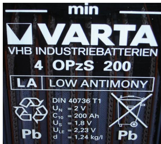
Figura 5.2 Datos de placa de las baterías.
