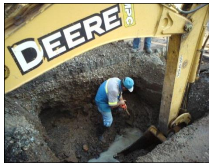
Figura 8. Reparaciones del alcantarillado sanitario de Pérez Zeledón.
