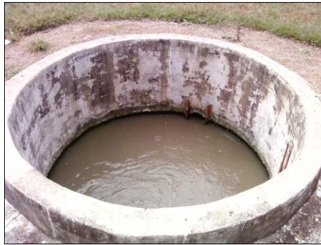
Figura 15. Cajas de Registro sin sistema de protección para los trabajadores.
