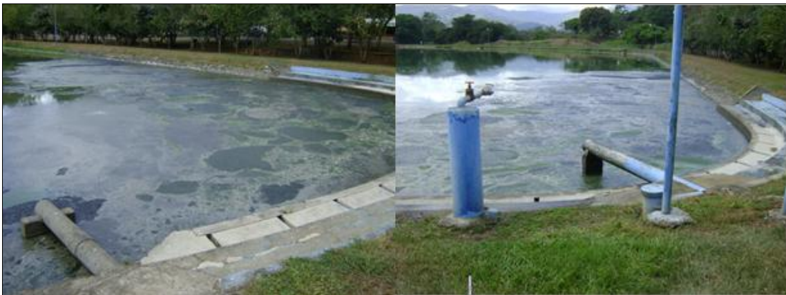
Figura 21. Cortos circuitos presentes en el sistema de tratamiento de Pérez Zeledón.
