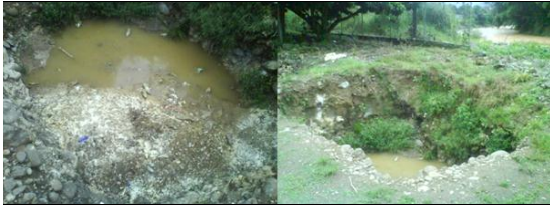
Figura 17. Fosa de sólidos del sistema de tratamiento de aguas residuales de Pérez Zeledón.
