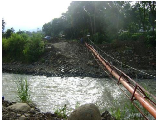
Figura 10. Paso elevado antes de realizar canalización del Río San Isidro.
