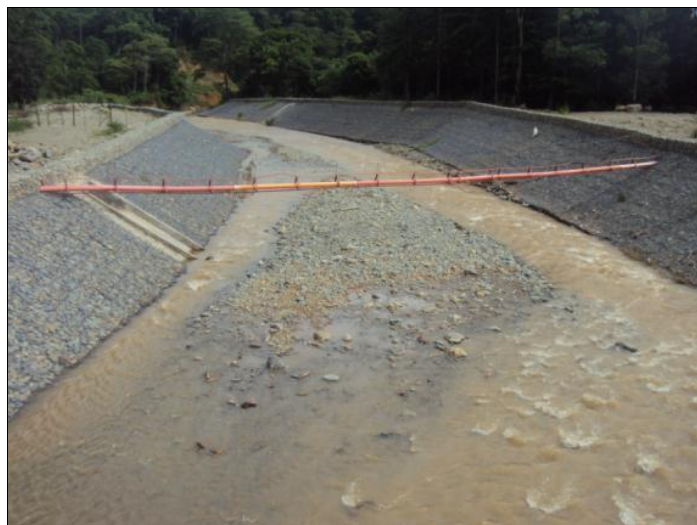
Figura 12. Estado actual del paso elevado sobre el Río San Isidro.
