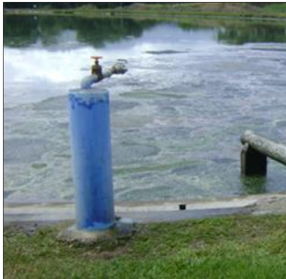
Figura 20. Llaves de paso para el control de sólidos suspendidos en el sistema lagunar de agua residual de Pérez Zeledón.
