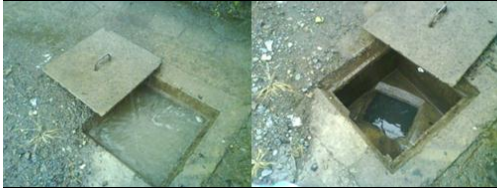
Figura 9. Variación de caudal en caja de registro del HEP durante y después de las lluvias.
