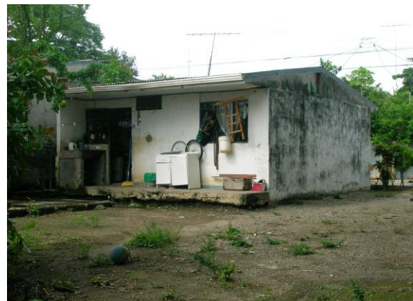
Figura 1. Casa construida con bloques de concreto ligero, Liberia, Guanacaste, enero de 1989.
