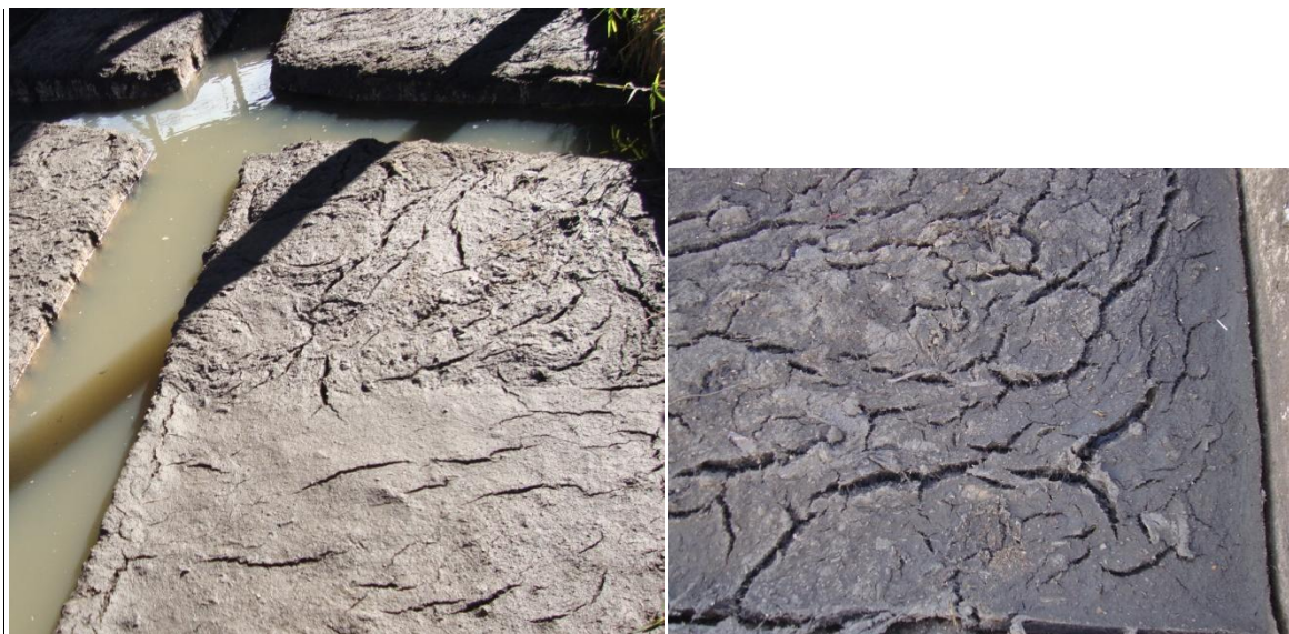
Figura 19. Fango en digestión en el lecho de secado
