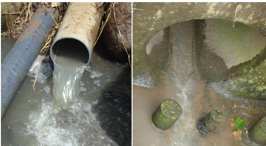
Figura 13. Salida de la PTAR al cuerpo receptor y salida del alcantarillado pluvial respectivamente
