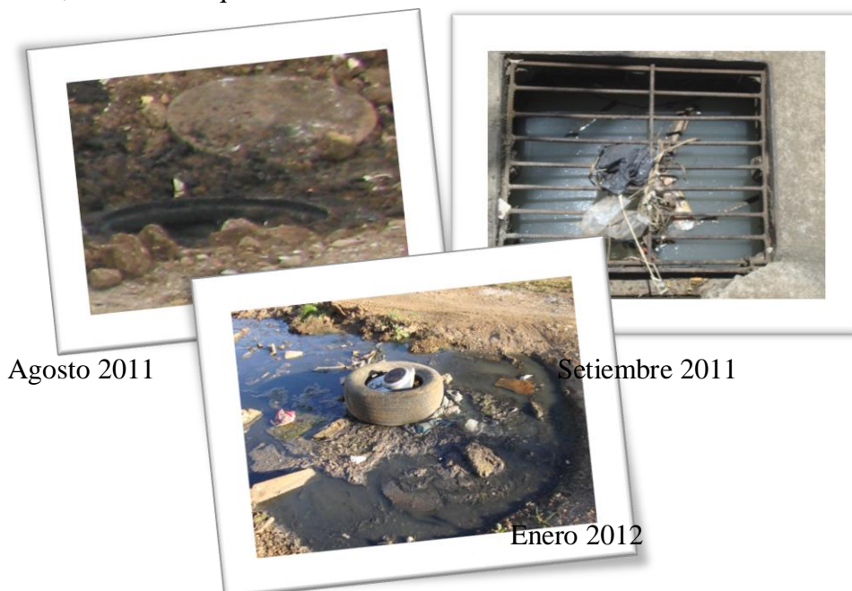
Figura 12. Registros y bajantes en los terrenos de menor nivel
