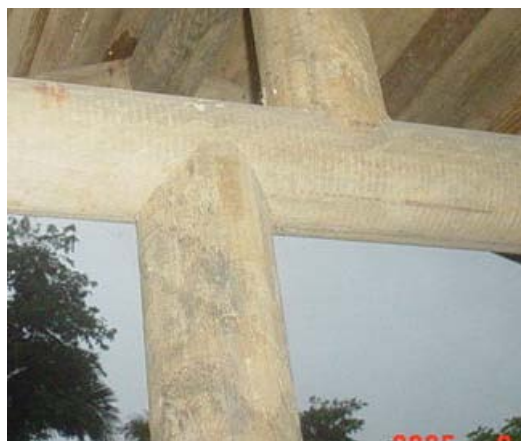
Figura 6: Caboteo para estructura de techo de Corredor
