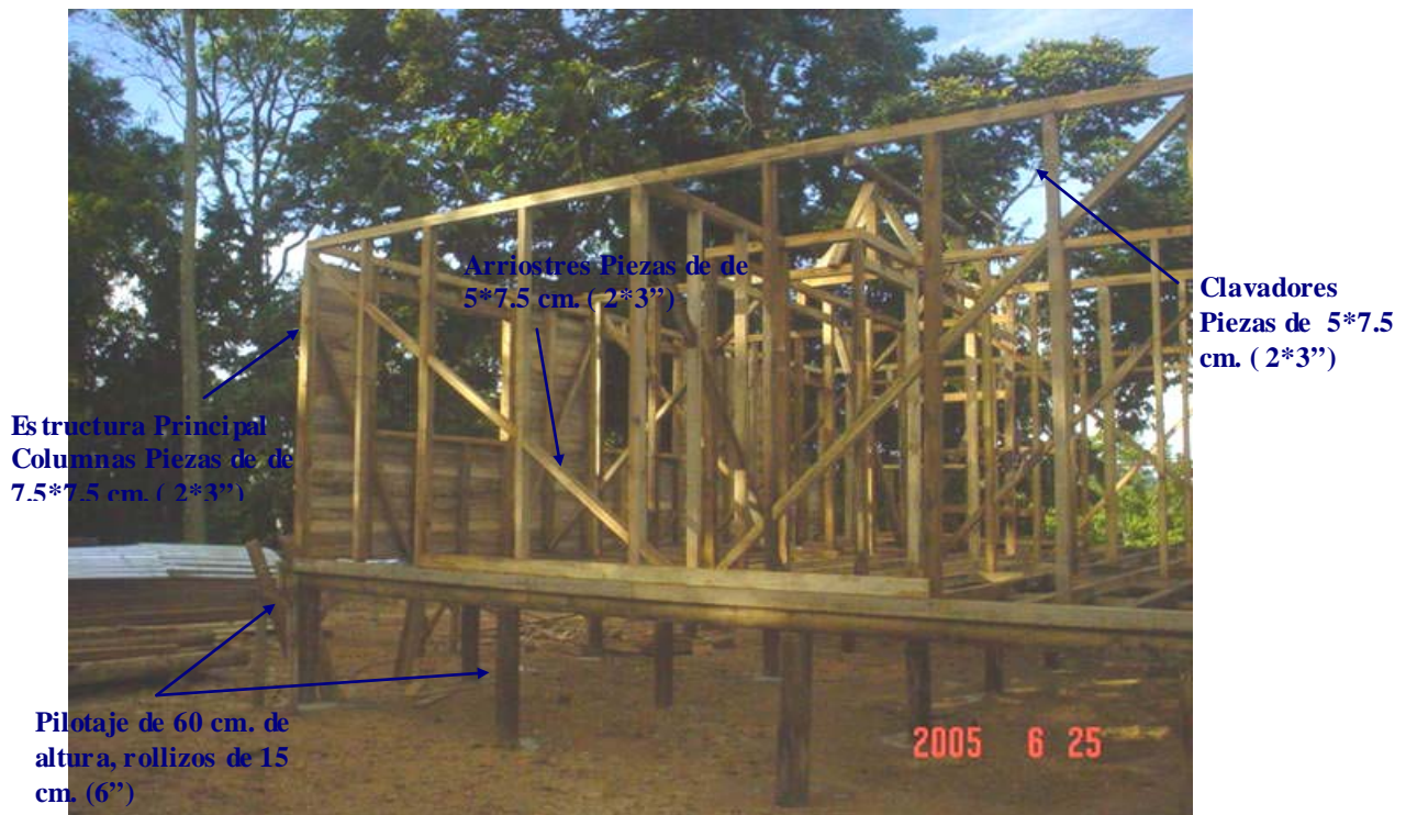
Figura 3: Muestra de Estructura de Pared y Pilotaje
