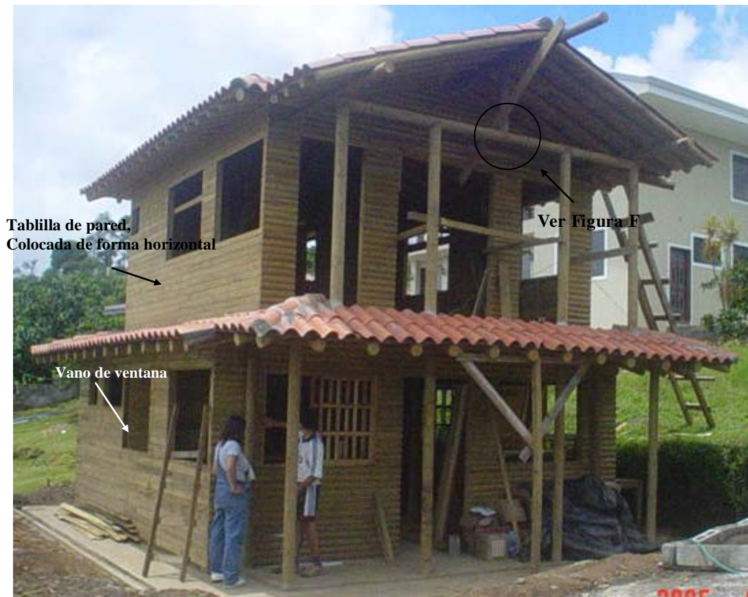
Figura 5: Fachada de una casa de dos plantas
