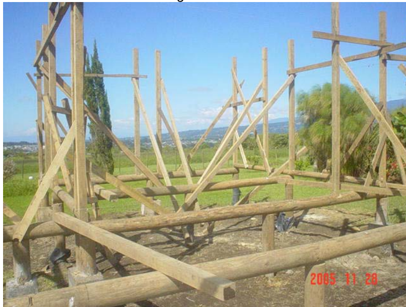
Figura 8: Estructura principal de entrepiso
