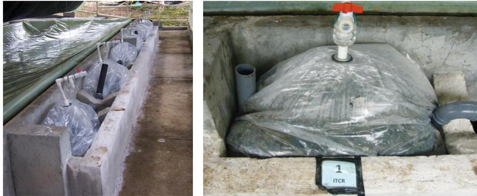
**Figura 6.** Biodigestores a escala del ITCR.
