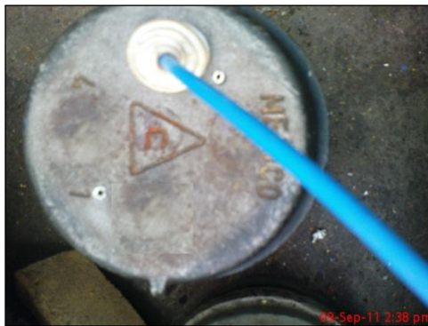
Figura 6.6 Montaje del transmisor de presión utilizado para el tanque 5 presente en el frente al Edificio Operadoras
