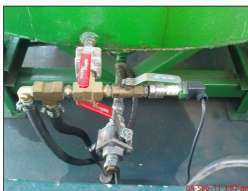
Figura 6.5 Montaje del transmisor de presión utilizado para el tanque 1 presente en el sótano del Edificio Principal
