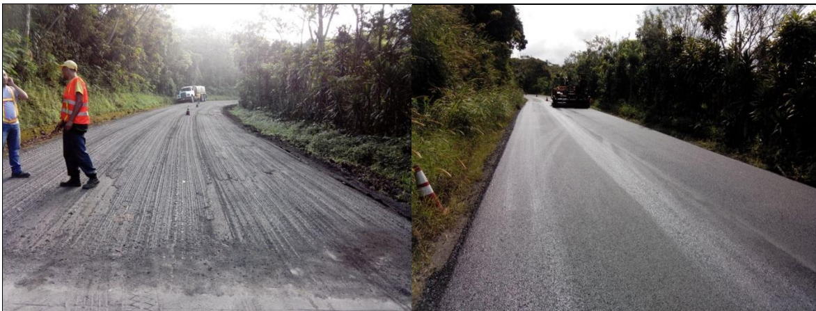
Figura 4.6. Actividades de perfilado de pavimentos y colocación de la sobrecapa asfáltica de 5 cm de espesor.
