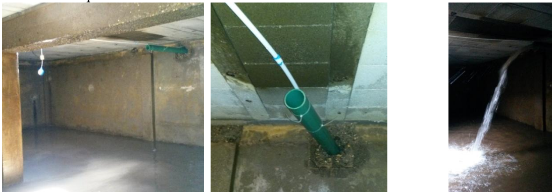
Figura A.10. 1. Registro fotográficos de los sitios posibles para realizar el aforo en la planta de tratamiento.
