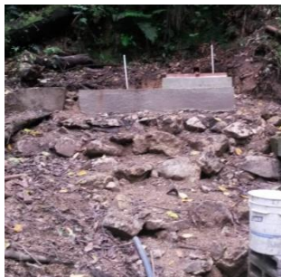
Estructura de captación
