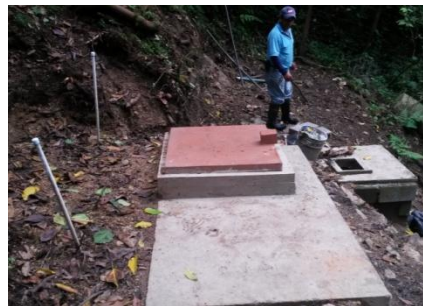
Estructura de captación
