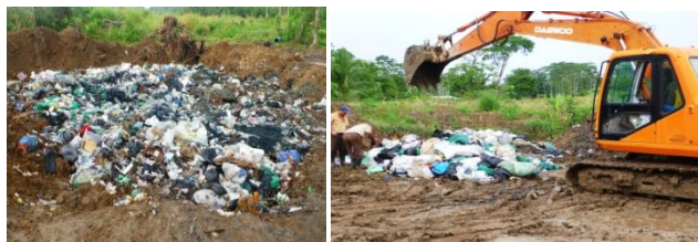
Figura 1.3. Fotografías del proceso de enterramiento de la basura en el vertedero municipal de Guácimo (tomada febrero 2013)
