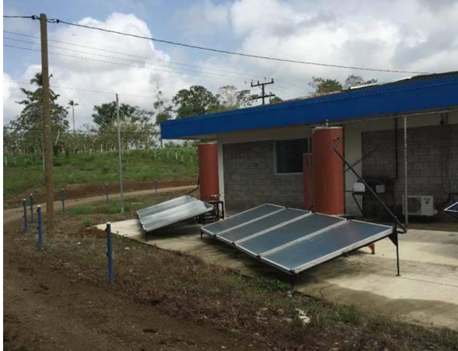
Figura 1. Equipo de colectores solares instalados en la lechería del ITCR sede San Carlos.
