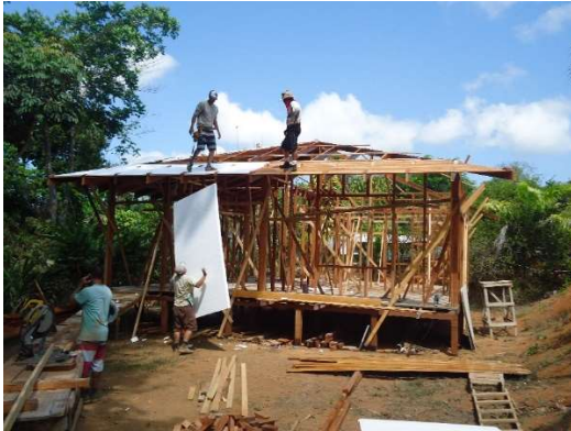
Figura 33: Construcción de la vivienda Fuente: Elaboración propia
