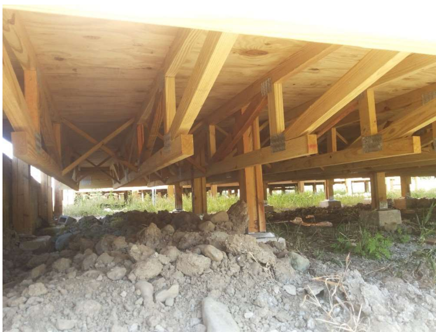
Figura 57, anexo: Sistema de entre piso de las viviendas y las uniones de las cerchas por medios de placas metálicas. Fuente: elaboración propia proyecto en Batán, Limón. Empresa Montelimar
