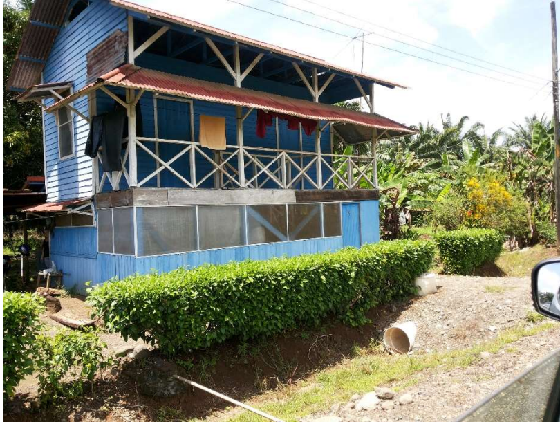
Figura 66, anexo: Viviendas en madera de la zona de Parrita Fuente: elaboración propia
