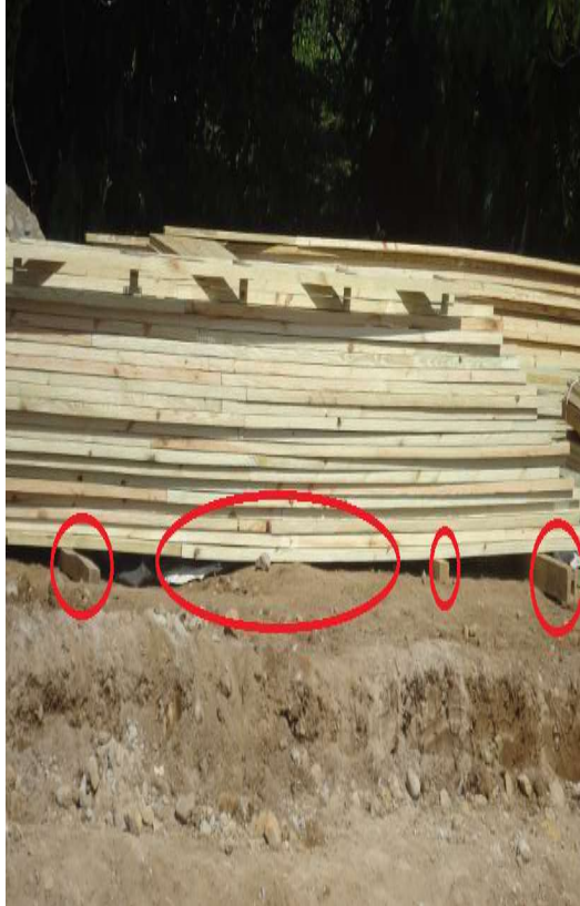
Figura 50. Mal almacenaje de la madera Fuente: elaboración propia
