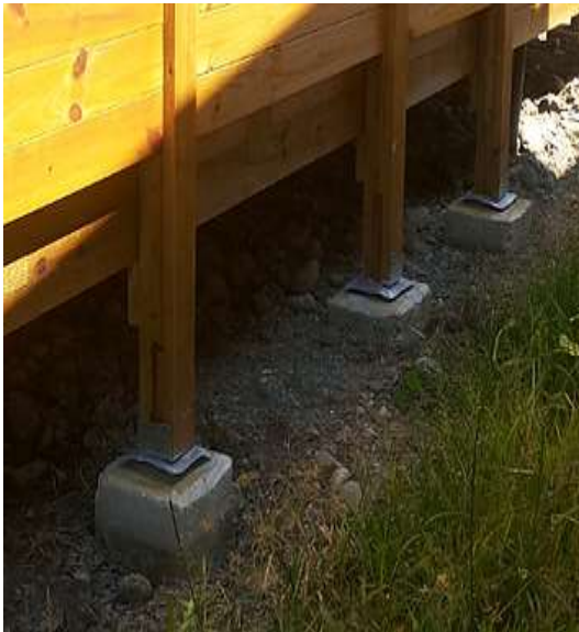
Figura 09. Colocación de protección a las columnas de la vivienda para impedir el paso de los insectos.
