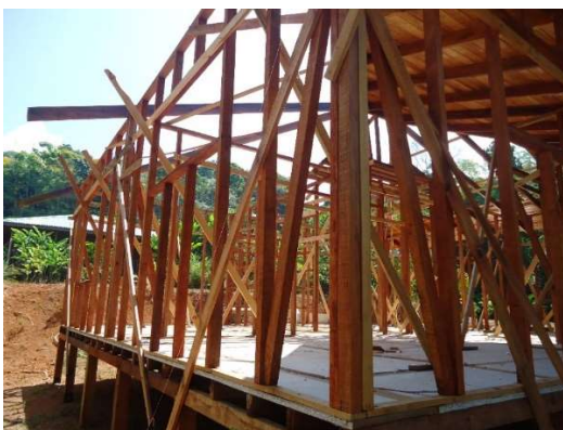
Figura 35: Construcción de la vivienda Fuente: elaboración propia
