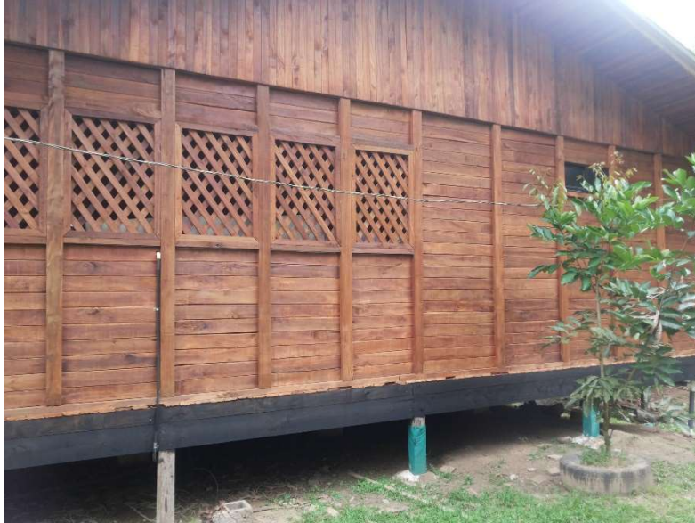
Figura 60, anexo: Vivienda elaborada con el sistema constructivo de la empresa Ecocajas. Fuente: elaboración propia
