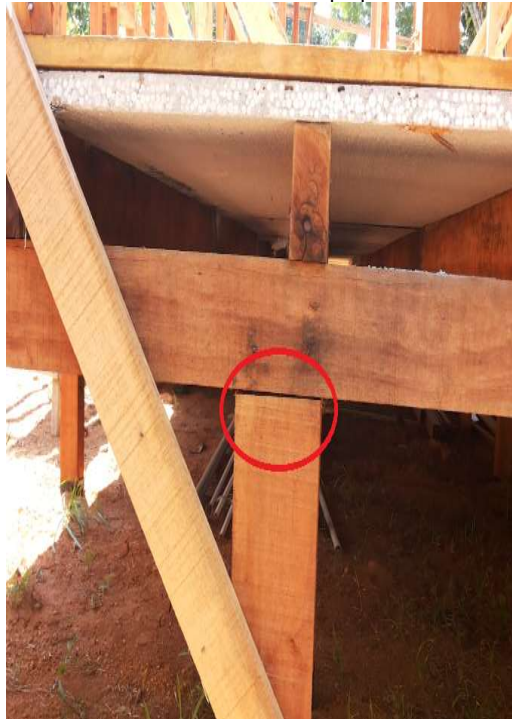
Figura 51. Mal apoyo de los elementos Fuente: Elaboración propia
