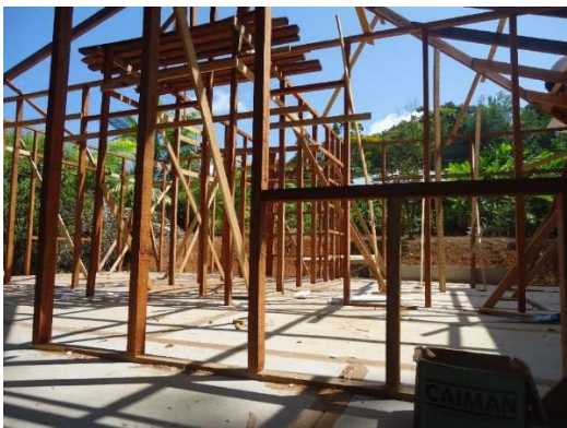
Figura 34: Construcción de la vivienda Fuente: Elaboración propia
