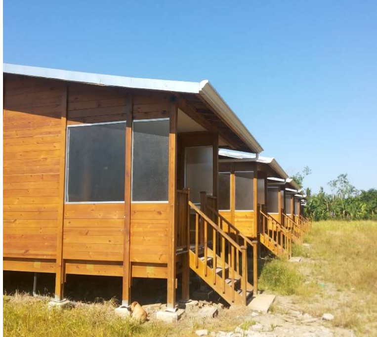
Figura 54, anexo: Casas sobre pilotes levantadas del suelo un aproximado de 0, 5 m Fuente: elaboración propia proyecto en Batán, Limón. Empresa Montelimar
