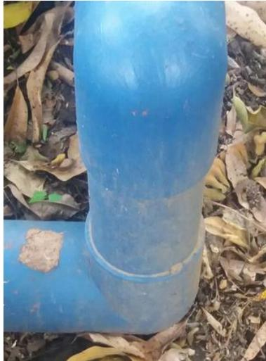
**Figura 2.10. Tubería de 4" SDR 21.**
