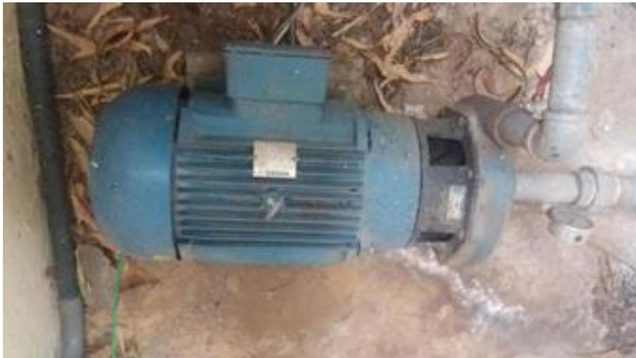
**Figura 2.6. Bomba principal del sistema de 25 HP.**
