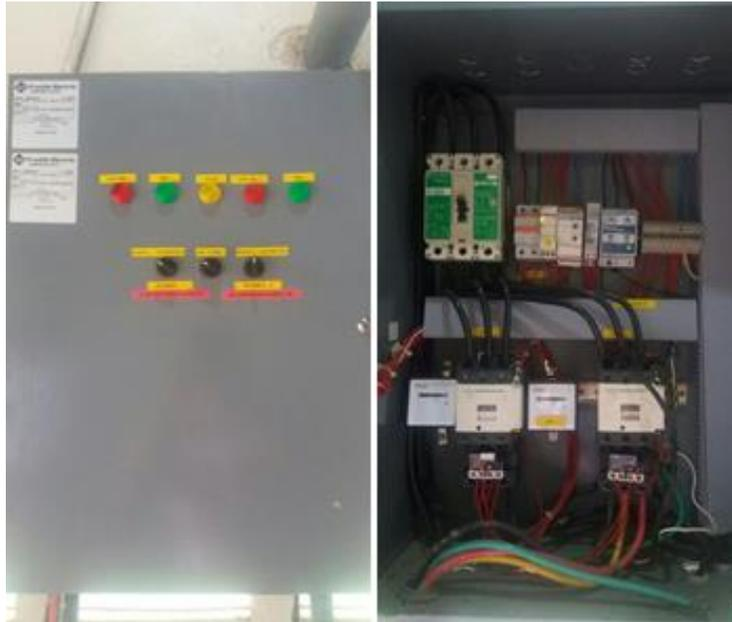
**Figura 2.9. Panel de control actual de las bombas.**
