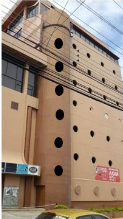
Figura V-9. Ventilación natural medio de egreso 2
