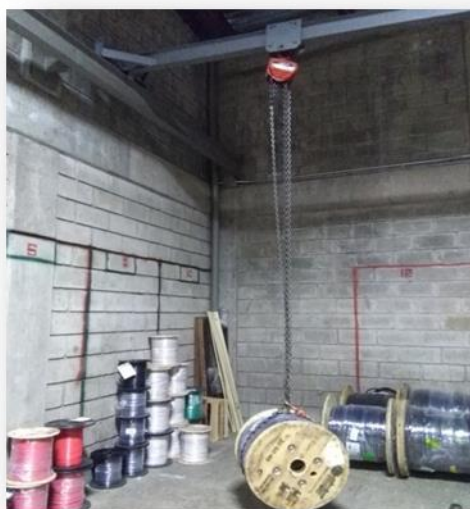
Figura 4. 5. Tecele para el levantamiento, transporte y montaje de tecles.
