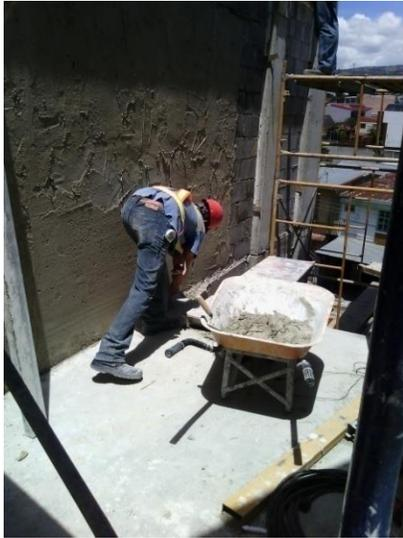
**Figura No.35:** Repello de paredes externas
