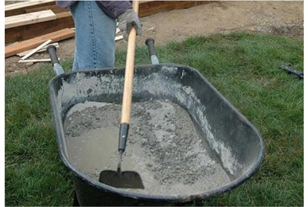
**Figura No.26:** Mezcla de mortero
