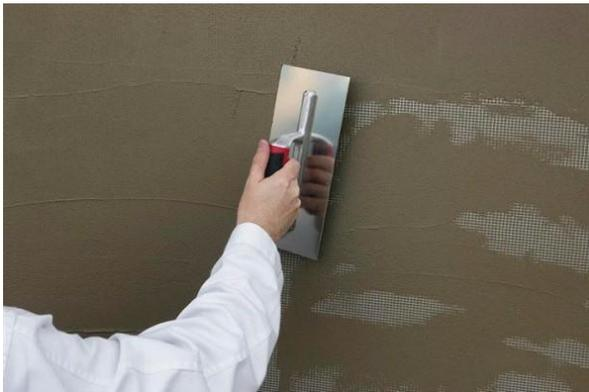
**Figura No.22:** Aplicación de mortero
