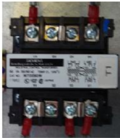
Figura A.2.4 Transformador de medición Siemens de 480V/120V.
