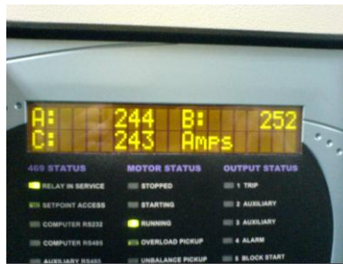
Figura A.2.7 Pantalla LCD del módulo 469 con datos de corriente.
