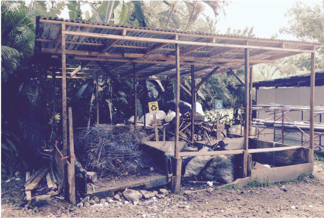
Figura 9. Zona de acumulación de residuos en la visita del 9 de setiembre, condominio Ventana.
