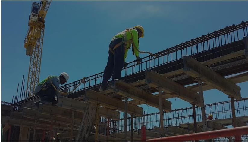
Figura 18. Colocación de formaleta lateral para viga en el edificio TIC'S.
