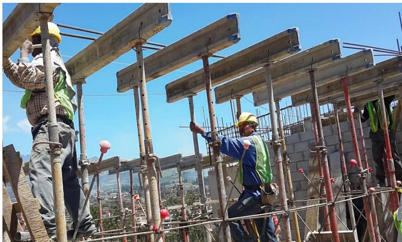
Figura 15. Colocación de formaleta base en el edificio TIC'S.
