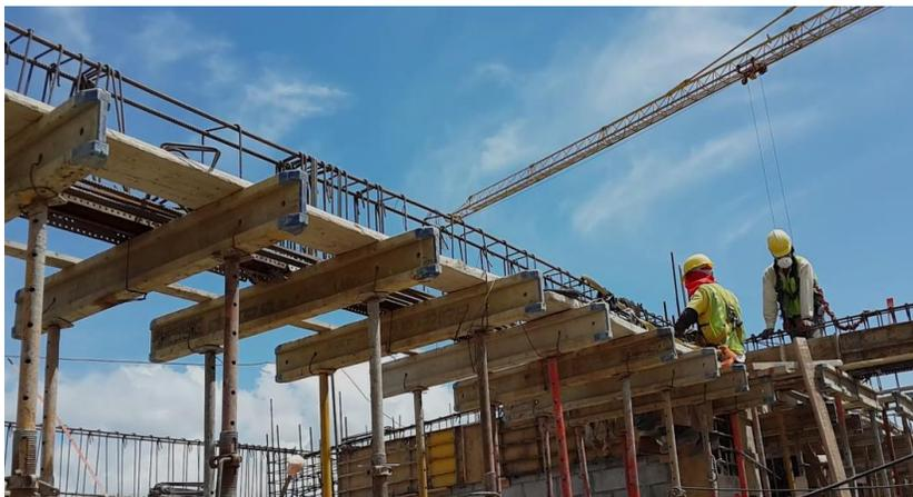
Figura 17. Armado de la estructura de viga en el edificio TIC'S.
