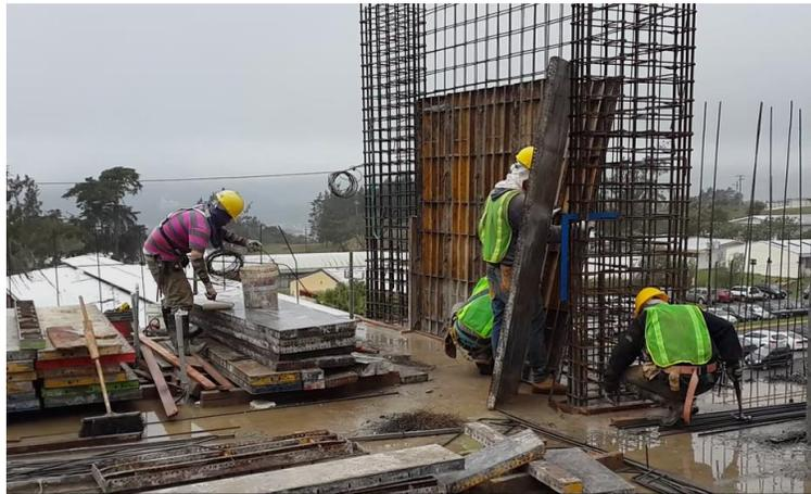
Figura 9. Colocación de formaleta en el proyecto TIC'S.
