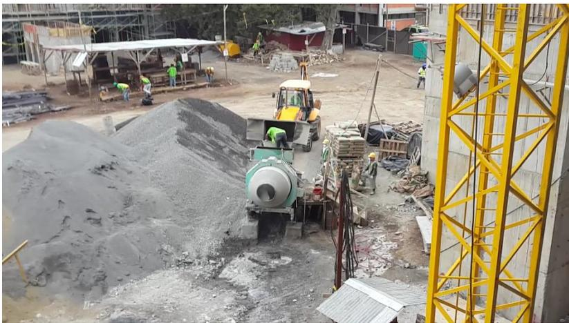
Figura 19. Fabricación de concreto para viga en el edificio TIC'S.
