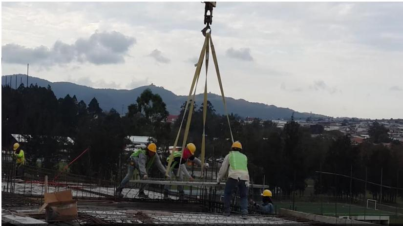
Figura 24. Colocación de losa prefabricada (Filigran) en el edificio TIC'S.
