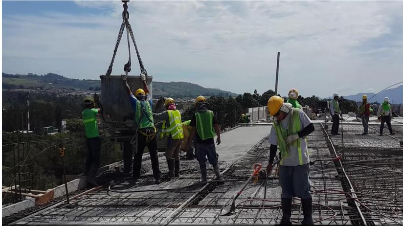
Figura 20. Colado de concreto para viga en el edificio TIC'S.
