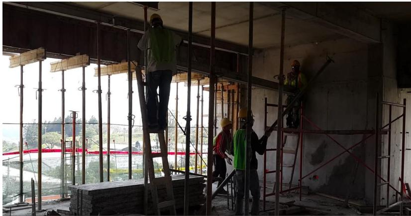
Figura 28. Desencofrado de losa en el edificio TIC'S.
