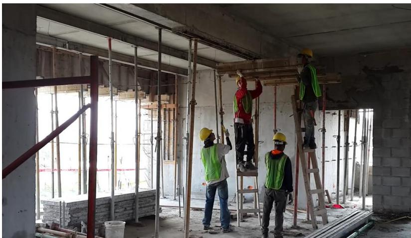
Figura 21. Desencofrado de viga en el edificio TIC'S.
