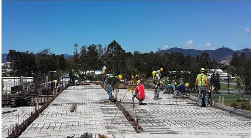
Figura 25. Colocación de armadura para losa en el edificio TIC'S.
