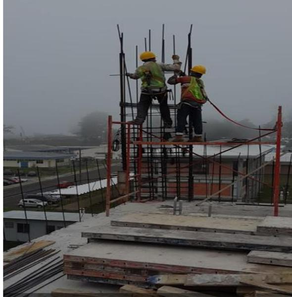
Figura 7. Armado de la estructura de columna del proyecto TIC'S.
