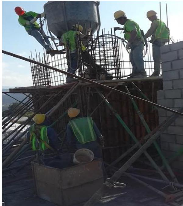
Figura 11. Colado de concreto en el proyecto TIC'S.
