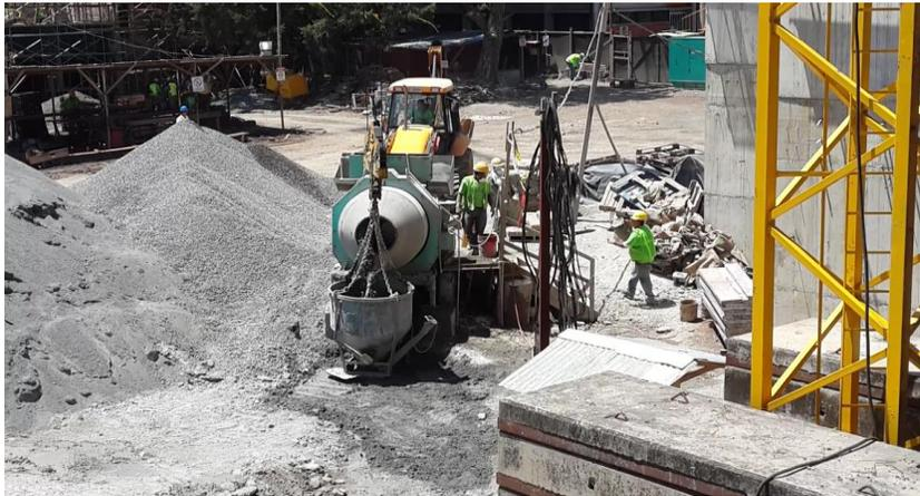
Figura 26. Fabricación de concreto en el edificio TIC'S.
