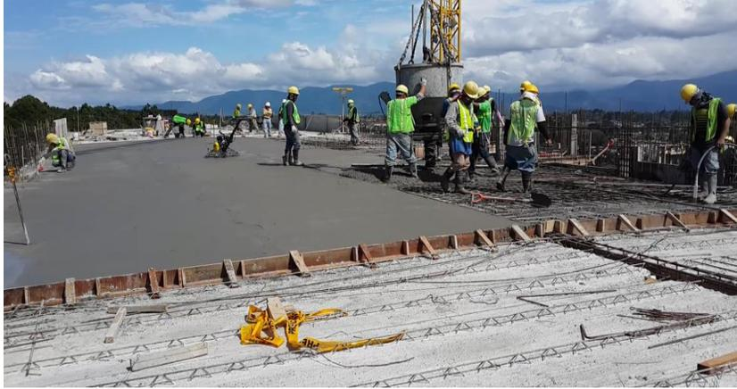
Figura 27. Colado de concreto en el edificio TIC'S.
