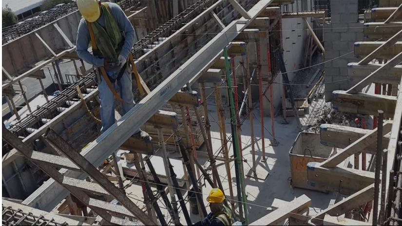
Figura 23. Armado de bases para estructura de losa en el edificio TIC'S.
