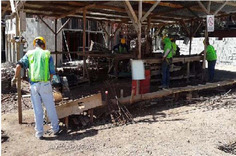
Figura 6. Cuarto de armadura del proyecto TIC'S.
