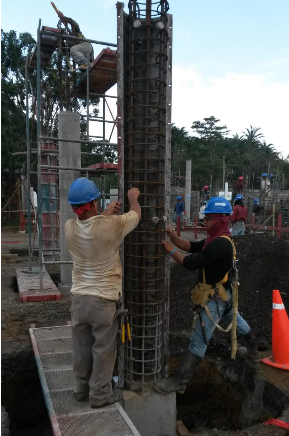
4.5 Colocando formaleta y helados a la armadura.
