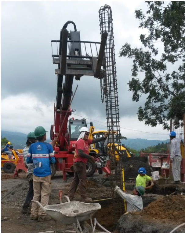
Figura 23. Fijación de Armadura al cimiento de la placa aislada
