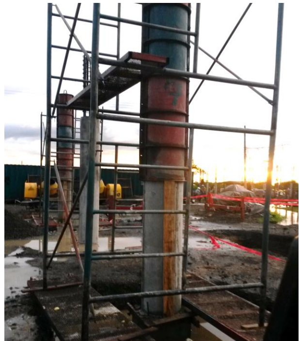
Figura 25 Encofrado en la parte Superior Fuente. Elaboración propia
