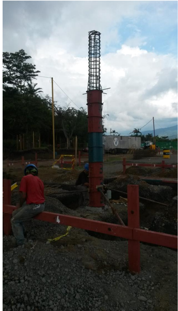
Figura 10. Colocación de la formaleta con sección circular. Fuente. Elaboración propia.
