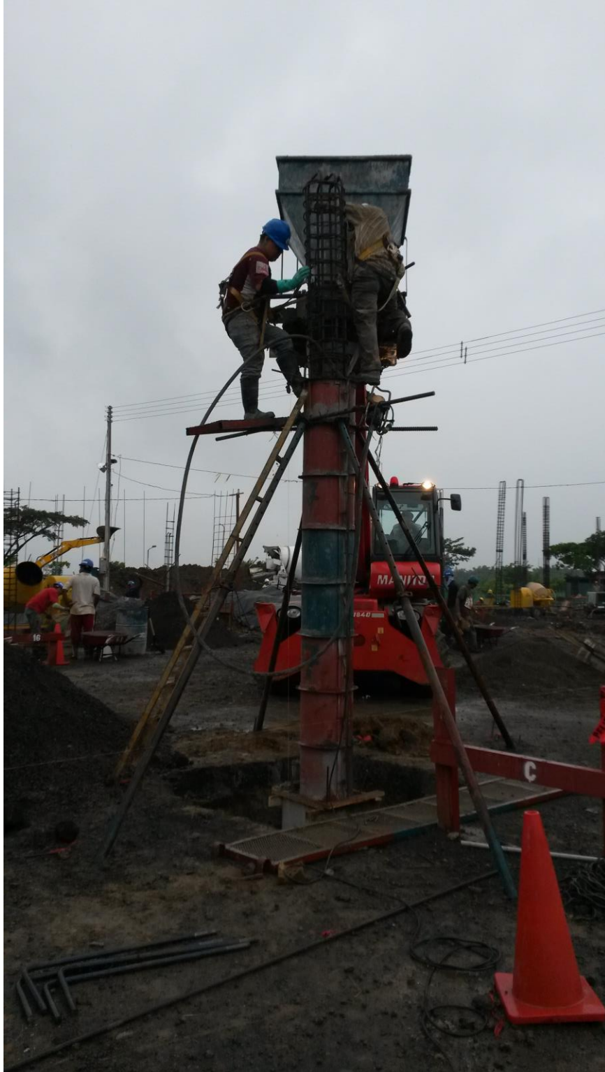
4.7 Chorrea de columnas, primera parte.
