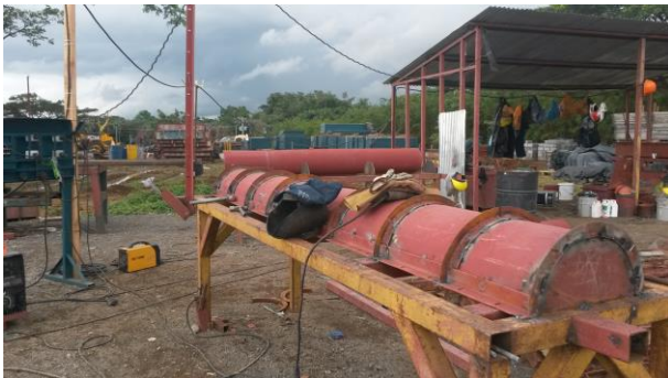
Figura 9. Elaboración de la formaleta con sección circular Fuente. Elaboración propia.
