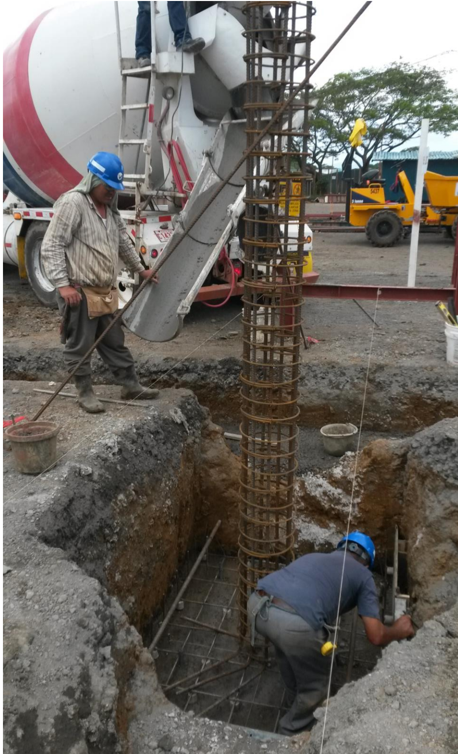
4.3 Armadura en sitio, y preparando para hacer chorrea de placa aislada.
