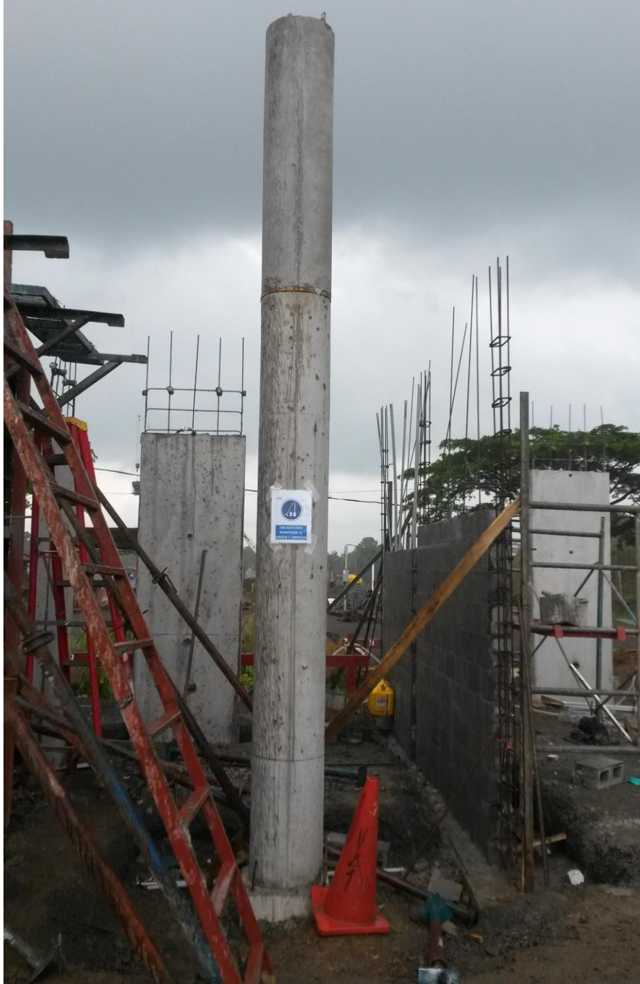
4.9 Segunda parte de columnas confeccionada, columna completa.
