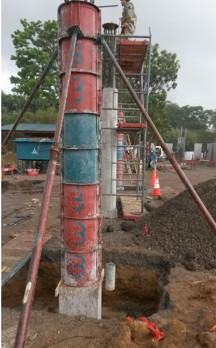
4.6 Formaleta, plomos y puntales colocados, estructura lista para la chorrea.
