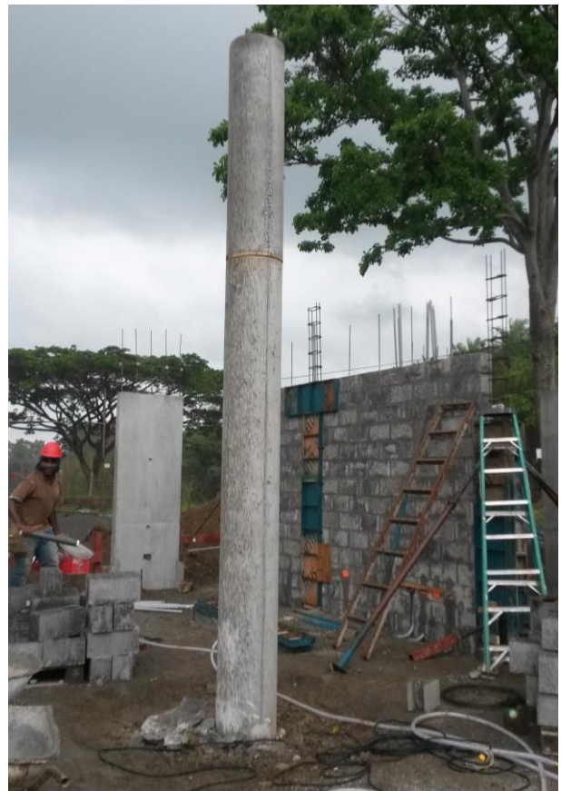
Figura28 Columna Circular terminada. Fuente. Elaboración propia.
