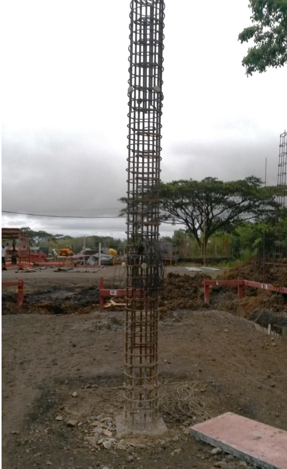
4.4 Placa aislada chorreada, armadura lista para colocar formaleta.
