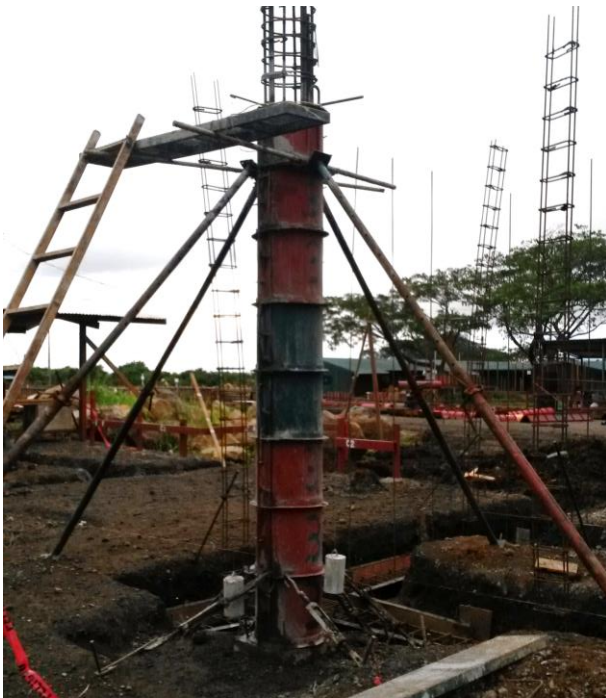
Figura 24 Encofrado en la parte Inferior Fuente. Elaboración propia.
