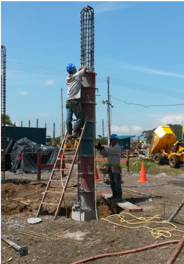
Figura27 Extracción de formaleta y accesorios. Fuente. Elaboración propia.
