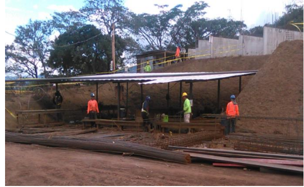
Figura 4. Sitio de trabajo de acero.
