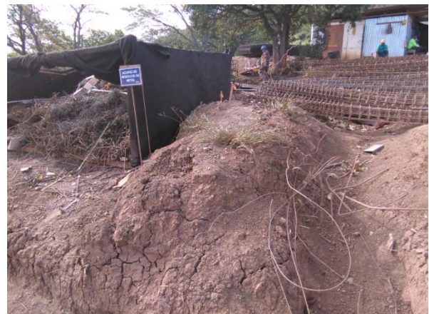
Figura 5. Centro de acopio de acero.
