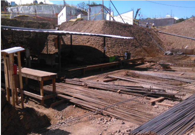
Figura 17. Zona de almacenaje de acero.
