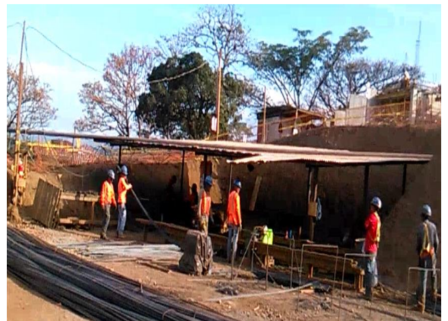
Figura 16. Taller de armadura de acero.
