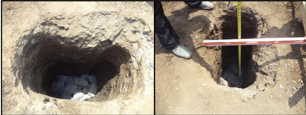
Anexo 3. Imágenes de Colocación de Piedra Bola
