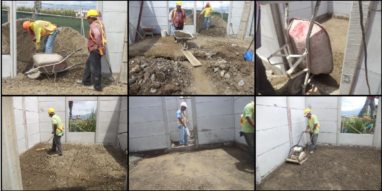
Anexo 11. Imágenes de Relleno de lastre Compactado
