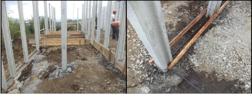
Anexo 7. Imágenes de Colocación de Formaleta
