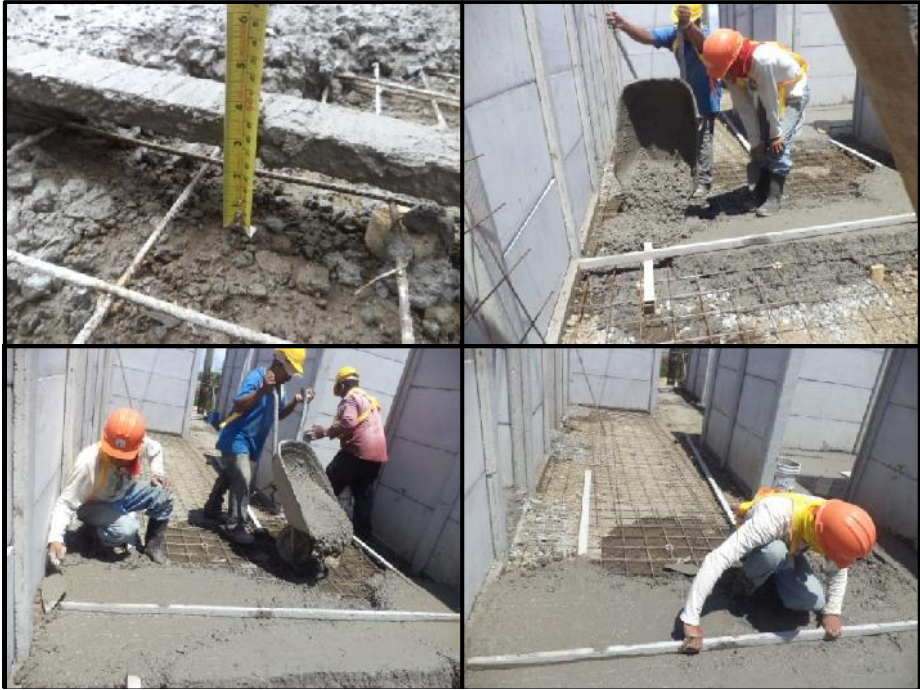
Anexo 13. Imágenes de Colado de Contrapiso
