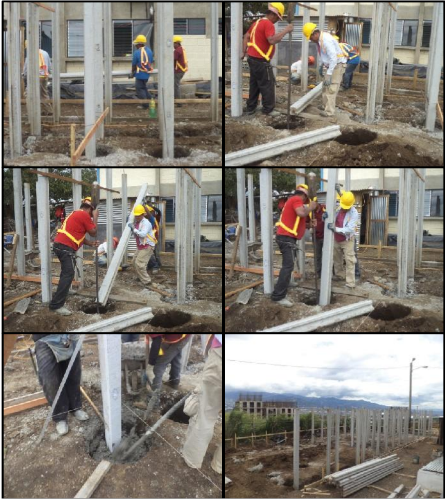
Anexo 8. Imágenes de Colocación de Columnas
