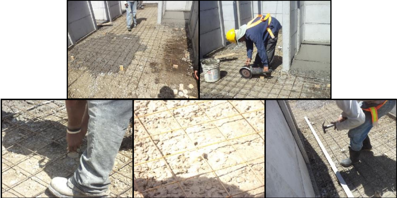
Anexo 12. Imágenes de Colocación de Malla Electro soldada
