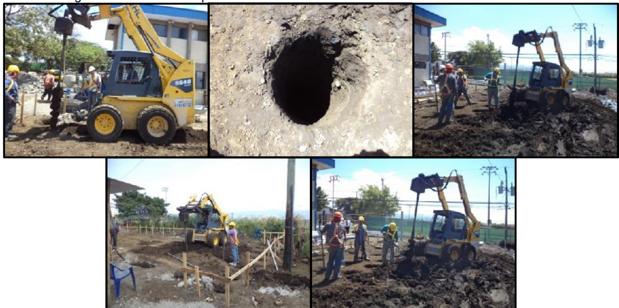
Anexo 2. Imágenes de Excavación para cimientos
