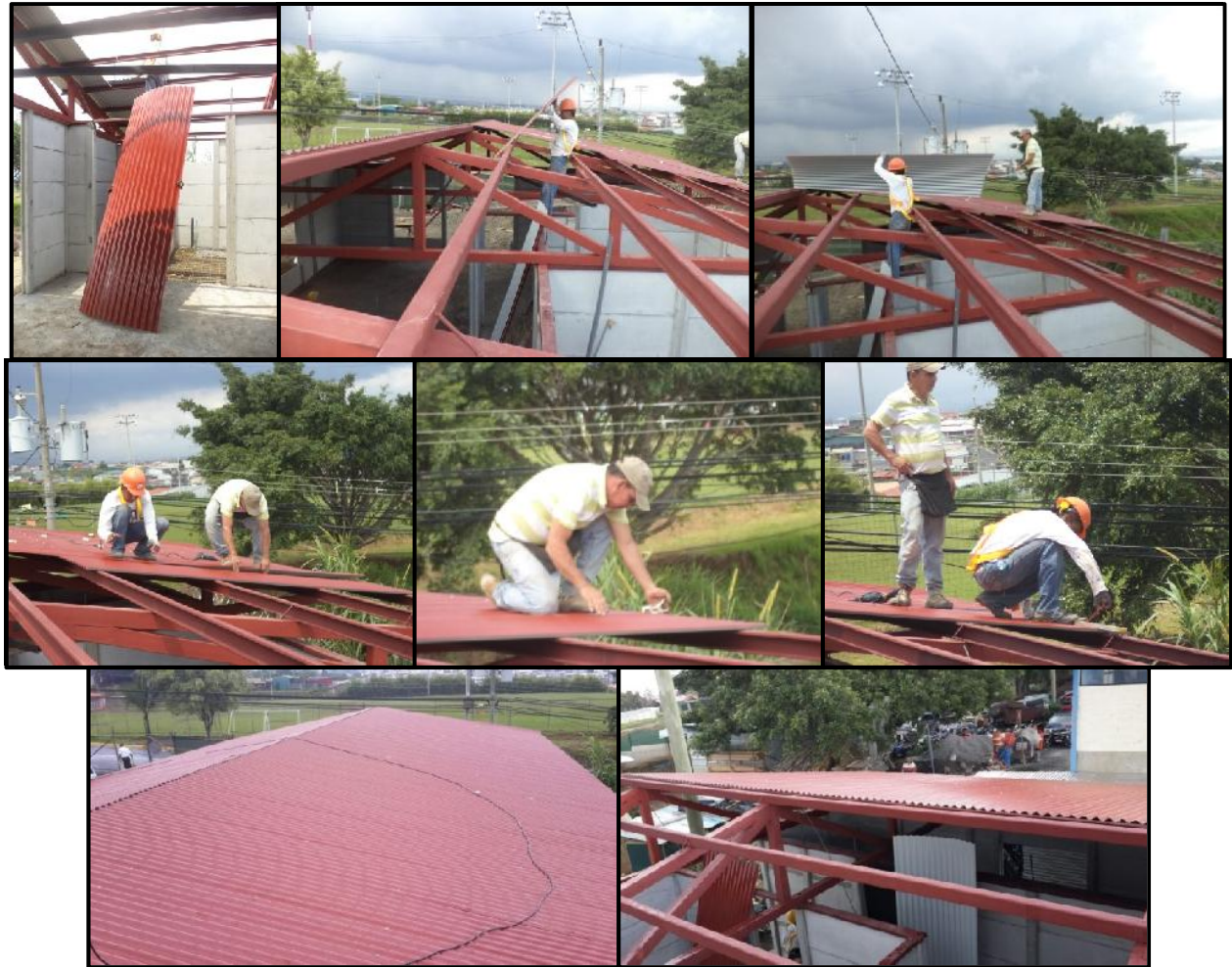
Anexo 17. Imágenes de Colocación de Cubierta
