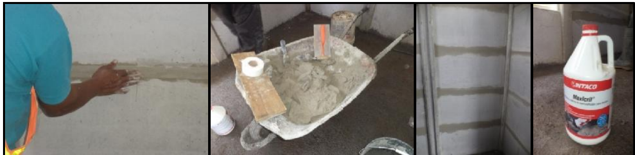
Anexo 18. Imágenes de Colocación de Maxicril, cinta malla y relleno de sisa
