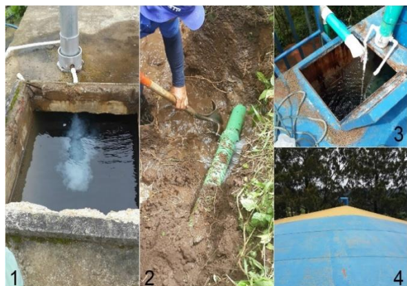
Figura 10 Visitas de campo realizadas durante la elaboración del proyecto; 1 proceso de cloración, 2 reparación de fuga, 3 y 4 – tanque 2000
